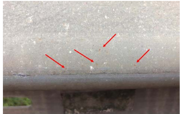
Bild 7: Kleine Rostpunkte an der verkehrszugewandten Seite eines Schutzplankenholmes nach 18-jährigem Einsatz am Mittelstreifen
