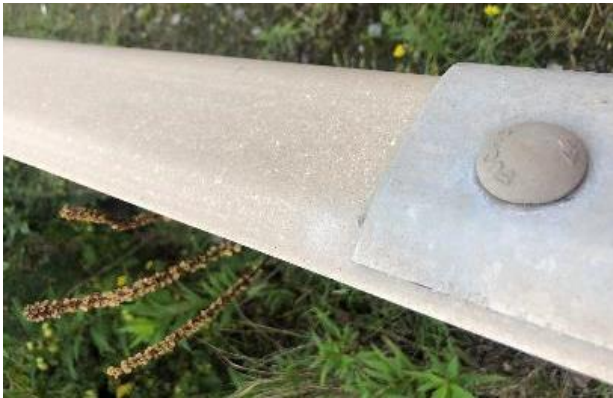
Bild 6: Kanten eines Schutzplankenholmes nach 18-jährigem Einsatz am Mittelstreifen ohne jegliche Anzeichen von Rotrost
