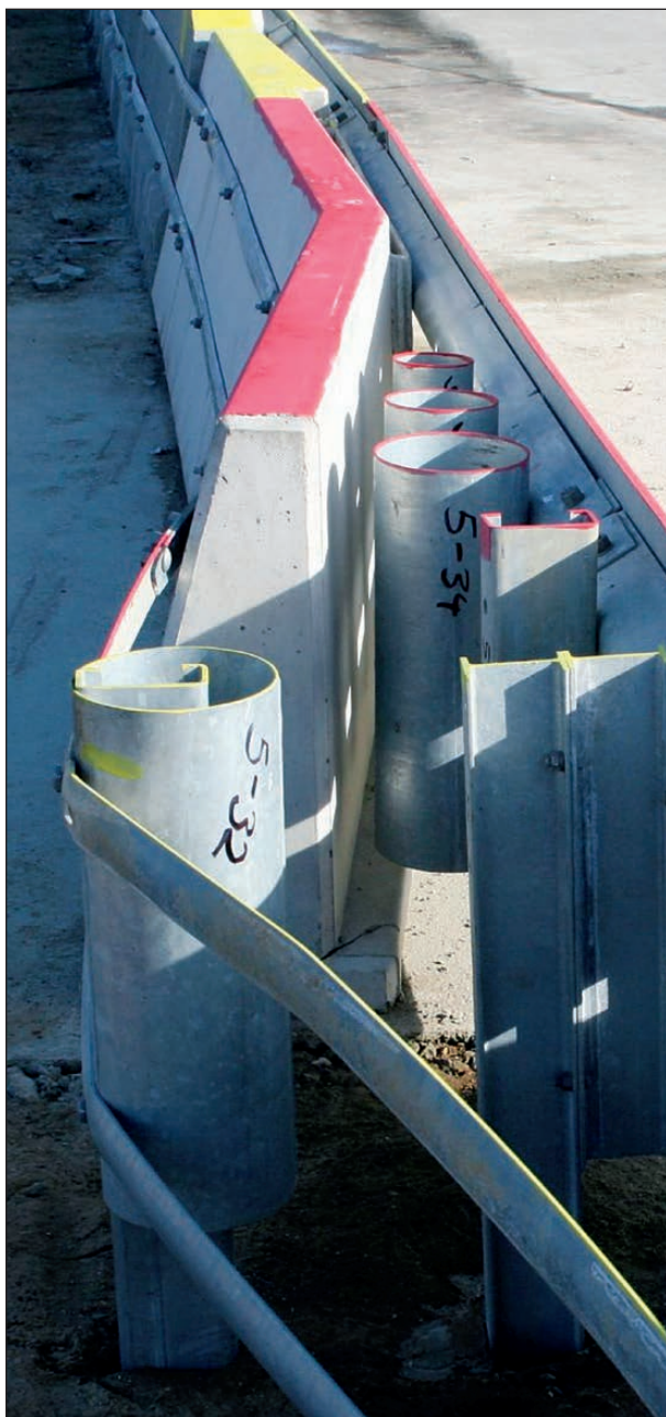
Bild 4-90: Anschluss an Betonfertigteil (Verziehungselement)
