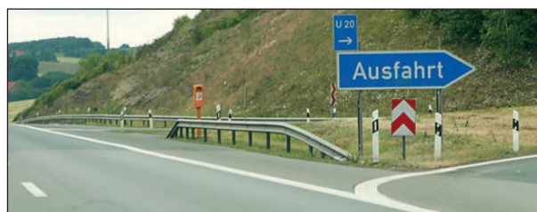
Bild 2-22: Notrufsäule mit ESP abgesichert
