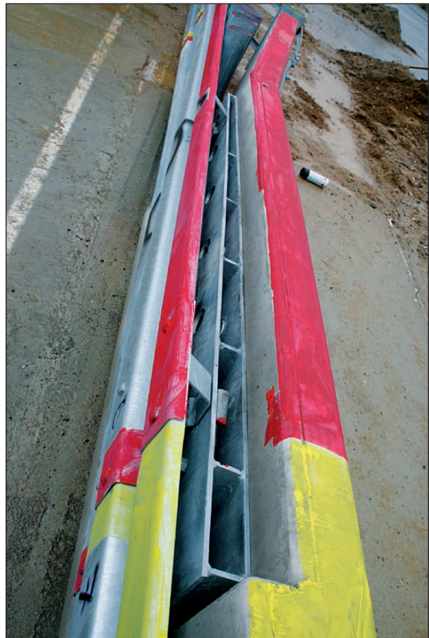
Bild 4-89: Detailansicht Übergang auf BSWO
