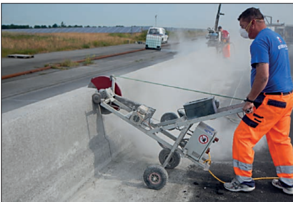
Bild 4-113: Durchtrennen der Bewehrung; Quelle: DEKRA
