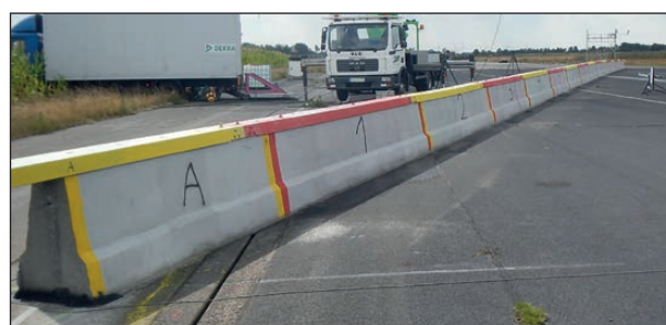
Bild 4-111: Übersicht BSWO mit aufgebrachter Sanierungslösung; Quelle: DEKRA
