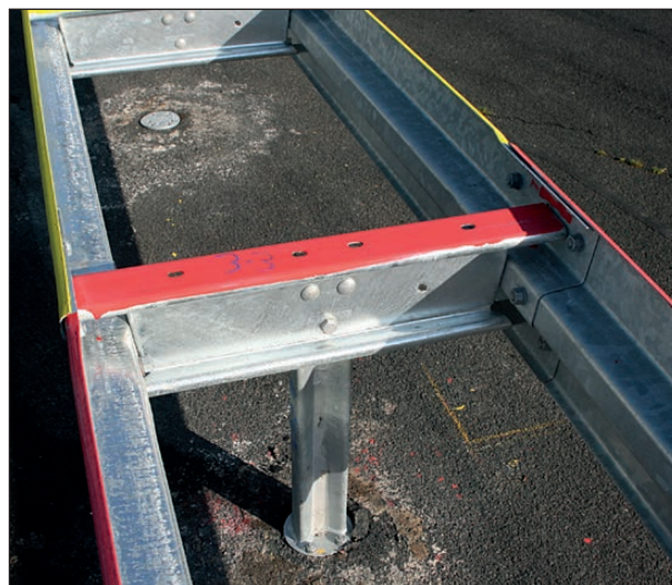
Bild 4-13: DDSP 4.0+ mit geschraubten Steckpfosten und Zusatzschraube zur Sicherung
