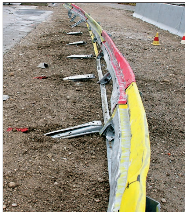
Bild 4-179: Verformungen des Systems; Blick entgegen der Anfahrtrichtung
