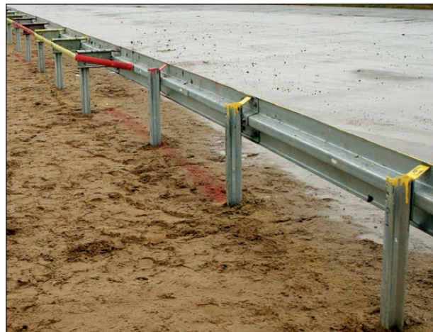
Bild 4-207: ÜK „ESP 4.00 – EDSP 2.0“ (Detailansicht)
