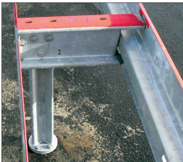
Bild 4-11: EDSP 2.0 mit geschraubten Steckpfosten und Zusatzschraube zur Sicherung
