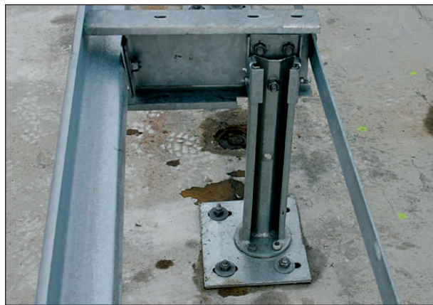
Bild 4-47: Detailansicht Verschraubung Pfosten
