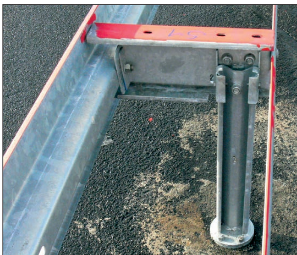
Bild 4-10: EDSP 2.0 mit geschraubten Steckpfosten und Zusatzschraube zur Sicherung
