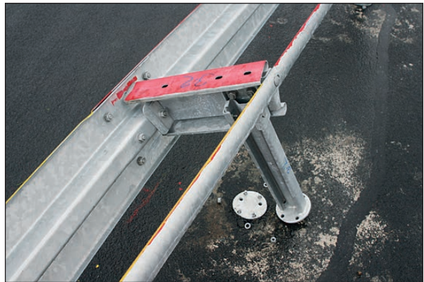
Bild 4-32: Vollständig gelöste Verschraubung bei Steckpfosten 3-2
