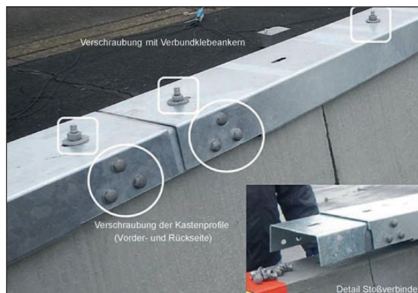
Bild 4-110: Aufgebrachte Sanierungslösung; Quelle: DEKRA/BAST
