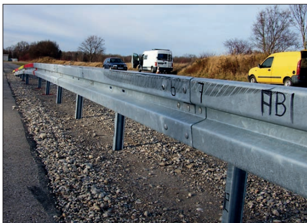
Bild 4-248: Abprallpunkt und Reifenspuren
