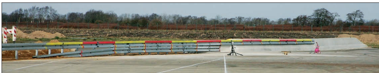
Bild 4-85: Übersicht über die vollständig montierte Übergangskonstruktion
