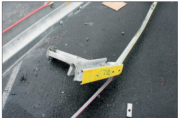
Bild 4-33: Detailansicht Pfosten und Abstandhalter 12-2 am Stoß 12/13 (Systemrückseite)
