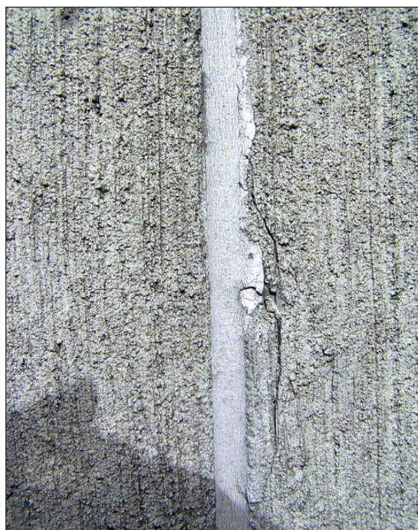
Bild 2-13: Poröser Fugenfüllstoff
