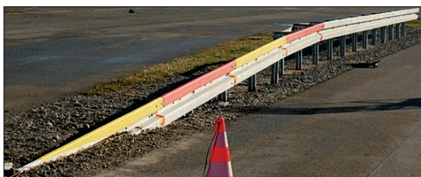
Bild 4-237: Übersicht über die montierte AEK; Blick in Anfahr- richtung
