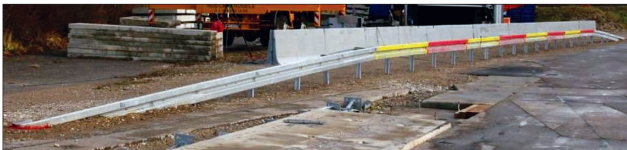
Bild 4-167: KurzedSP 2.0; Blick in Anfahrriichtung
