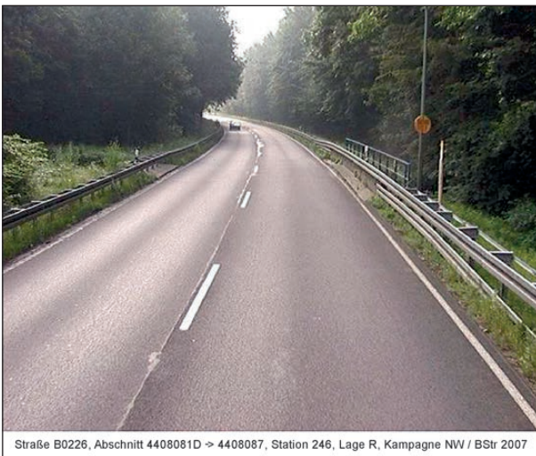
Bild 2-24: Kurze Brücke (Quelle: IT-ZEB Server)
