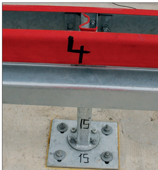
Bild 4-184: Befestigung auf Bauwerk
