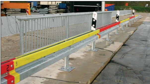
Bild 4-195: Detailansicht System vor der Prüfung; Blick in Anfahrtrichtung und den zusätzlich angebrachten Aufsatzleitpfosten
