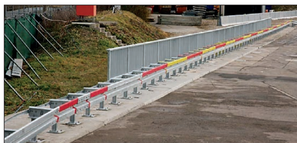
Bild 4-72: Übersicht über das vollständig montierte Fahrzeugrückhaltesystem; Blick in Anfahrriichtung
