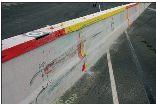
Bild 4-117: Übersicht über die Situation nach der Prüfung (Kontaktstrecke); Blick in Anfahrtrichtung
