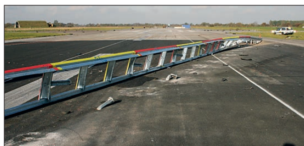
Bild 4-44: Übersicht ab Stoß 9/10 mit den aus dem Asphalt gezogenen Rohrhülsen der Pfosten 9 und 10
