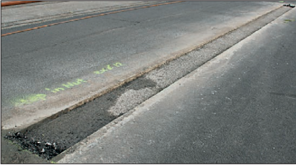
Bild 4-141: Asphaltnut für BSW O im Step-Profil; Quelle: DEKRA
