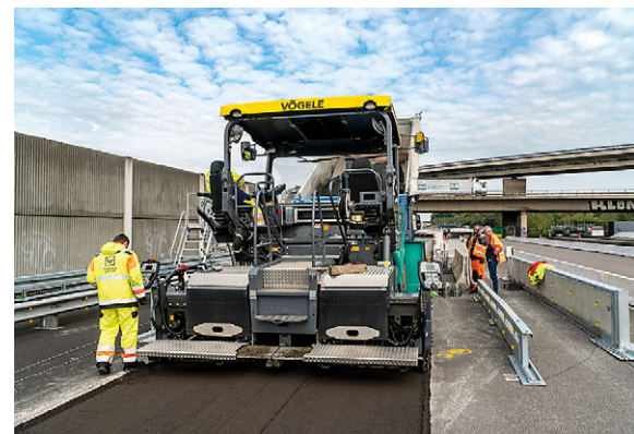
Ablauf Einbau Kaltrecyclingschicht auf dem duraBAST
