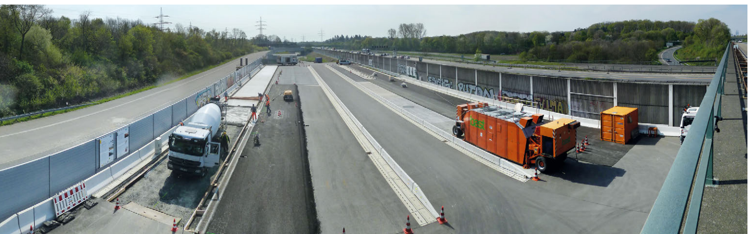
Einbau Betonfahrbahn auf dem duraBAST (links) – rechts der Mobile Load Simulator MLS30
