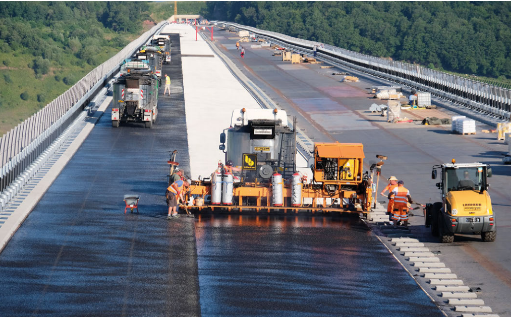
Einbau der Schutzschicht aus Gussasphalt am 28.06.2019
