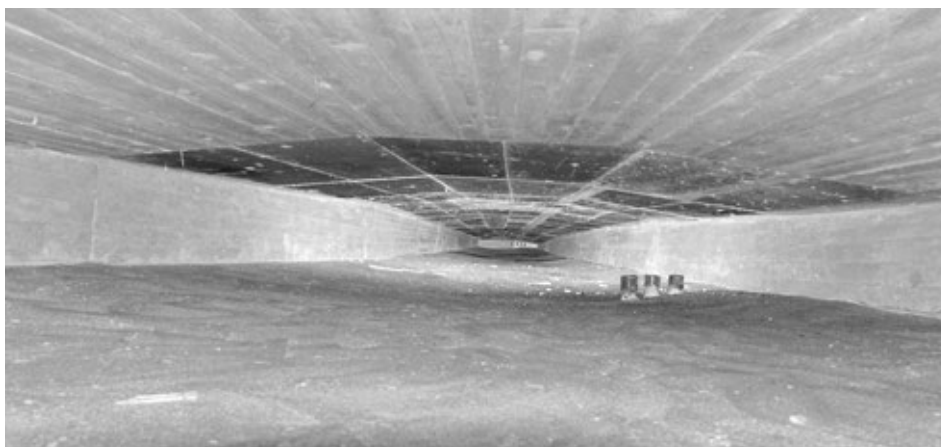
Punktwolke aus dem Laserscan im Hohlkasten
