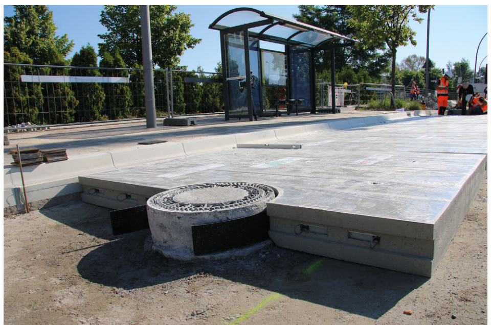
Fertigteil mit Aussparung im Bereich eines Schachtbauwerkes nach Verlegung und Höhenjustierung
