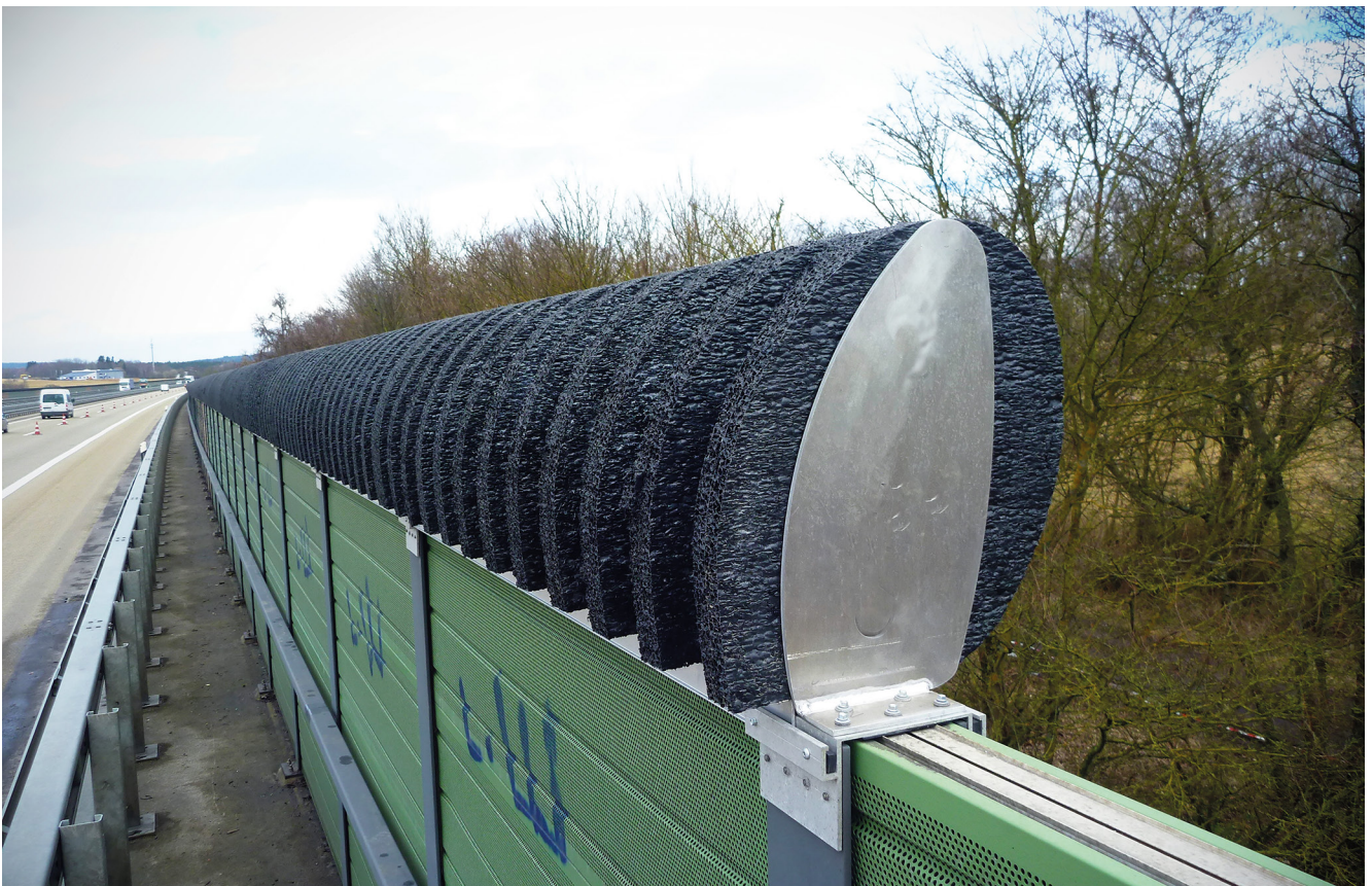
Lärmindernder Aufsatz aus Flüsterschaum auf einer Lärmschutzwand (Bild: Andre Jaborek, Hessen Mobil)
