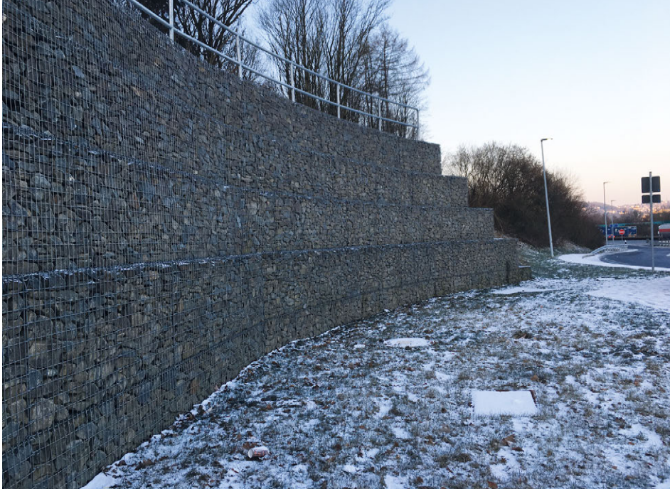
Stützmauer aus Gabionen
