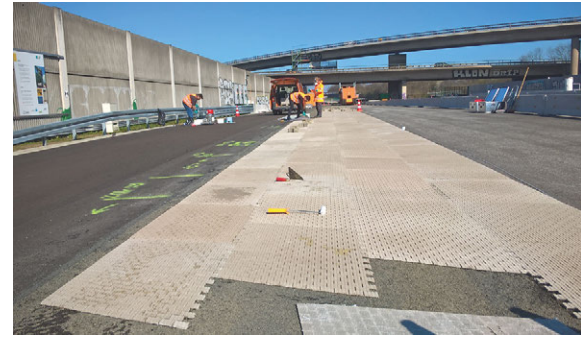
Herstellung des Inno-Pave-Belags
