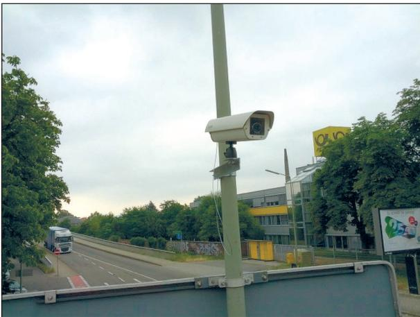
Bild 3-4: Befestigung einer Kamera an einem Lichtmast
