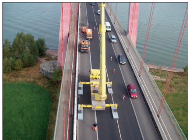
Bild 8.2: Berücksichtigung der Pratzendrücke
