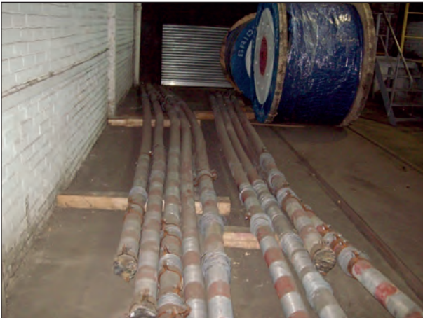
Bild 4.3: Ausgebaute Seilabschnitte (Übersicht)
