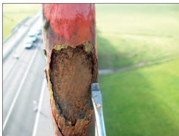
Bild 7.2: Beispielschaden für Kategorie 4
