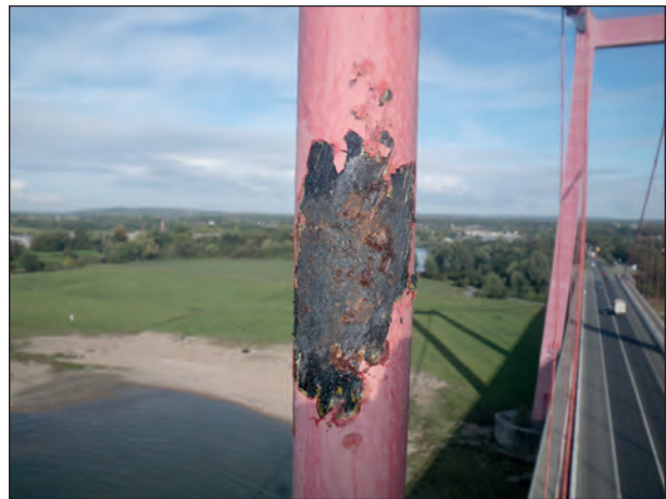
Bild 3.61: Beispiel für 4. Schadenkategorie: 1. Drahtlage Blattrost, 2. Drahtlage angerostet
