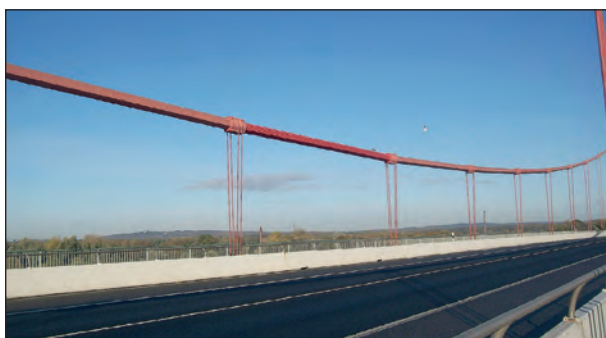
Bild 3.47: Ansicht der Hängerseile in Brückenmitte
