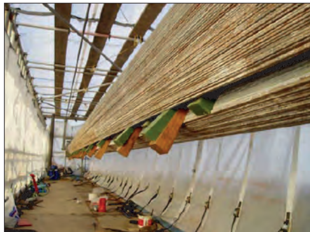
Bild 8.5: Tragkabel der Fort Road Bridge
