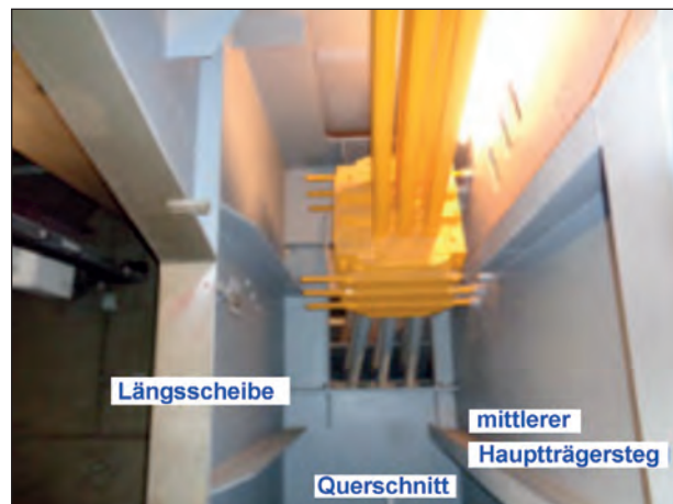
Bild 2.10: Vorderseite der Verankerung
