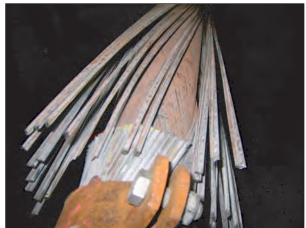
Bild 6.5: Geöffnetes Seil – 1. Drahtlage entfernt
