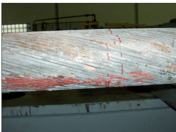
Bild 4.56: Drahtbruch außerhalb des korrodierten Bereiches mit großem Versatz
