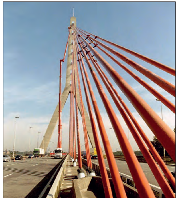
Bild 3.33: Steiger an der Brücke im Einsatz (Bild: Boué Ingenieure)
