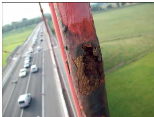
Bild 7.3: Beispielschaden für Kategorie 5
