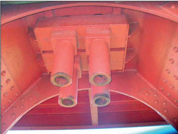
Bild 3.50: Verankerung der Hängerseile unterhalb des Brückendecks
