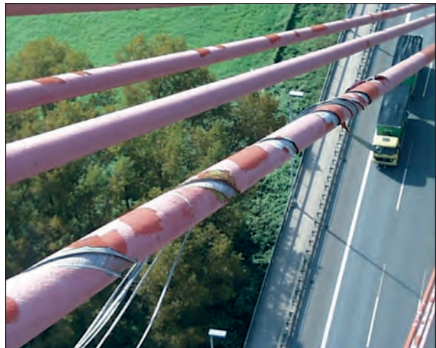
Bild 3.38: Verbund über 5 Schläge gelöst
