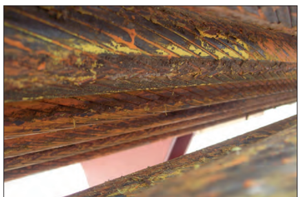
Bild 8.12: Freigelegte Seilebene
