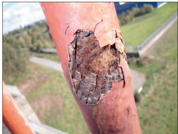
Bild 3.62: Beispiel für 5. Schadenkategorie: 2. Drahtlage Blattrost, 2. Drahtlage angerostet
