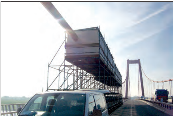
Bild 8.8: Einhausung des mittleren Bereiches des Tragkabels
