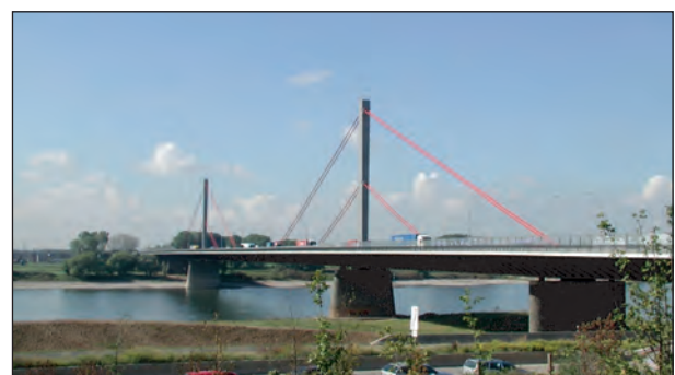
Bild 7.24: Kabelanordnung bei der Rheinbrücke Leverkusen
