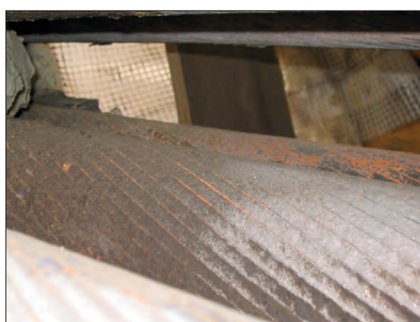
Bild 3.14: Zustand nach dem Strahlen
