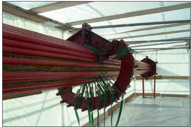
Bild 8.10: Spezielle Klemmkonstruktion zum Auseinanderziehen der einzelnen Seile
