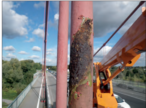
Bild 3.60: Beispiel für 3. Schadenkategorie: 1. Drahtlage Blattrost
