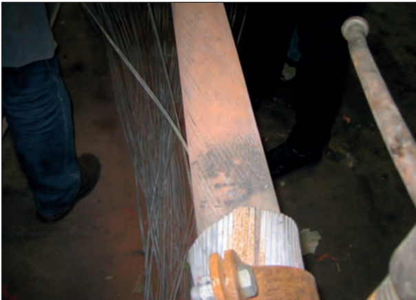
Bild 6.7: Geöffnetes Seil – 2. Drahtlage entfernt
