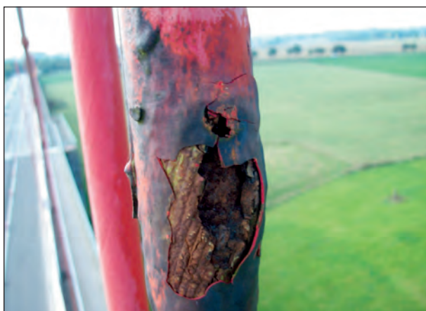
Bild 7.1: Beispielschaden für Kategorie 5
