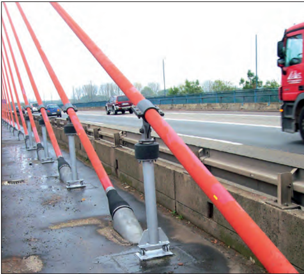
Bild 2.3: Rheinbrücke Bonn Nord – unterer Seilbereich oberhalb des Brückendecks
