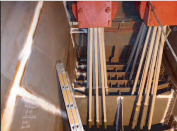
Bild 7.25: Seile werden zwischen Traversen hindurch geführt
