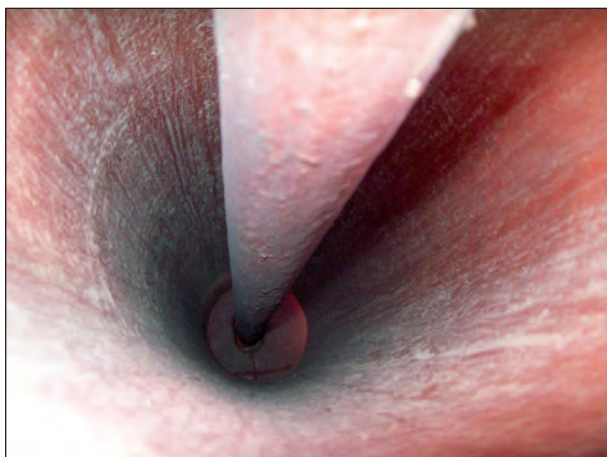
Bild 3.63: Blick in den Seilbereich unterhalb der Haubenabdichtung
