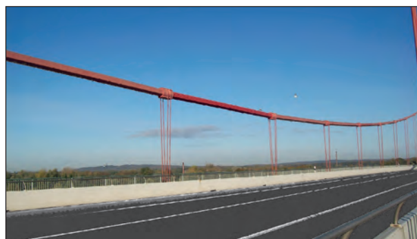
Bild 8.6: Mittlerer Bereich des Tragkabels ohne Ummantelung
