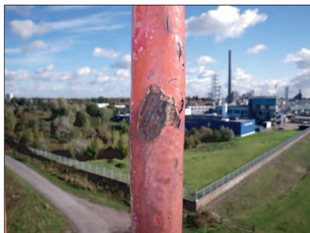
Bild 7.4: Beispielschaden für Kategorie 3 mit Drahtbrüchen
