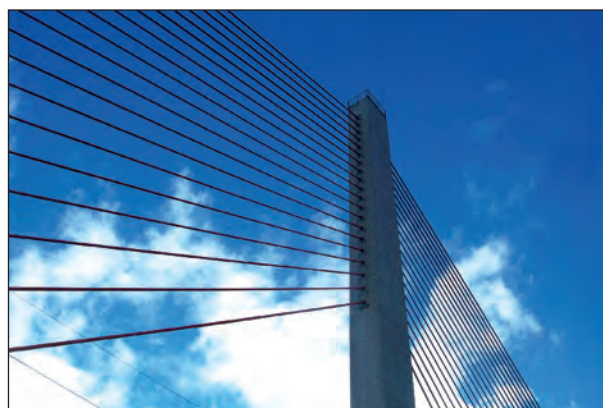
Bild 2.2: Rheinbrücke Bonn Nord – Seilverankerung am Pylon
