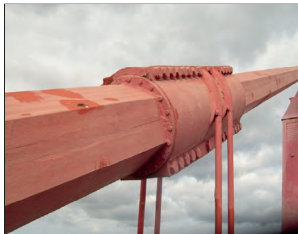
Bild 3.48: Umlenkung der Hängerseile um das Tragkabel
