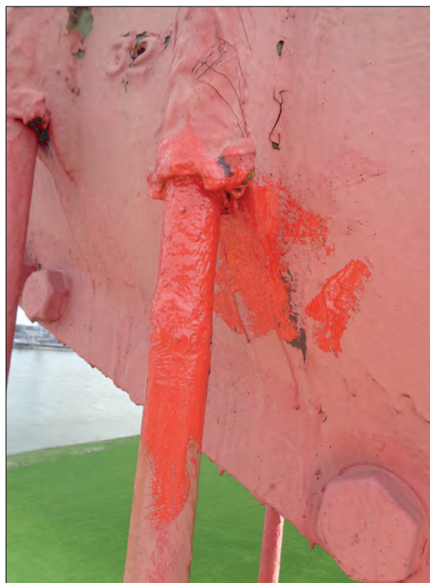
Bild 8.22: Seil nach dem Entfernen von Rost mithilfe eines Bristle Blaster
