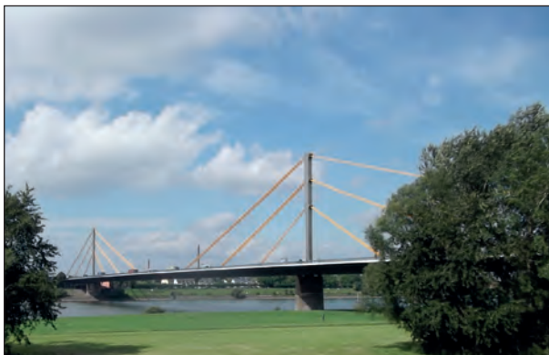
Bild 3.1: Rheinbrücke Duisburg Neuenkamp
