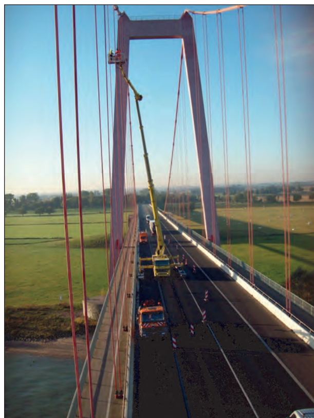
Bild 8.1: Einsatz eines Hubsteigers
