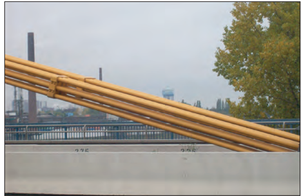
Bild 3.23: Seilkopplungen zur Reduzierung der freien Länge
