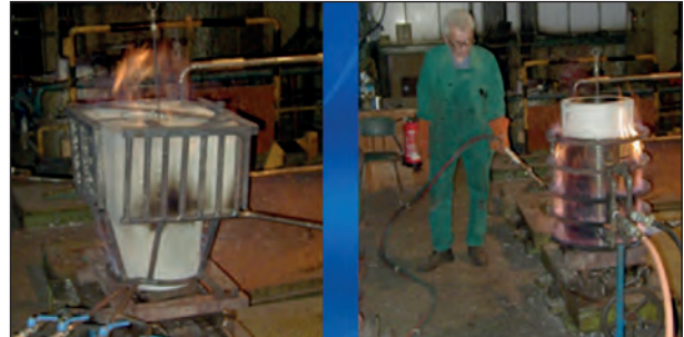
Bild 4.8: Vorwärmen der Seilköpfe im bereits ausgerichteten Zustand
