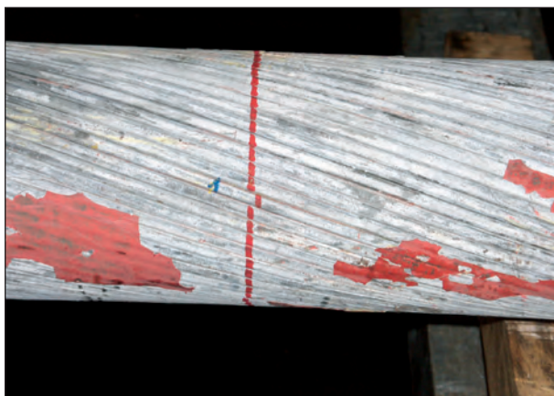
Bild 4.54: Erster Drahtbruch mit geringer Verschiebung, genaue Lage nicht ermittelbar
