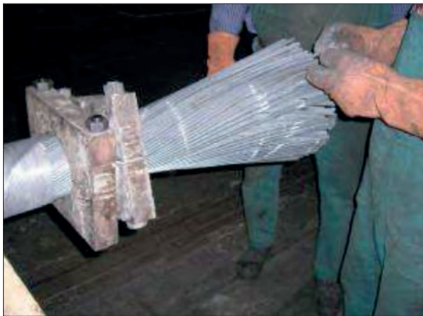
Bild 4.5: Öffnen des Drahtbesens
