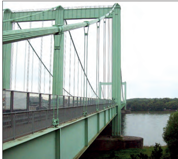
Bild 2.4: Rheinbrücke Rodenkirchen mit Blick auf das Tragkabel und die Hängerseile
