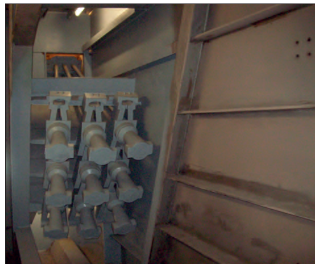
Bild 2.11: Rückseite der Verankerung
