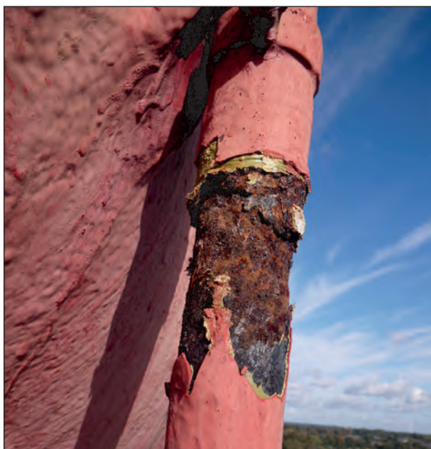
Bild 8.20: Beispielschaden vor dem Entfernen des Blattrostes
