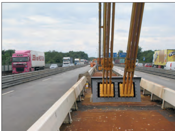
Bild 3.10: Gespreizte Kabel im unteren Bereich
