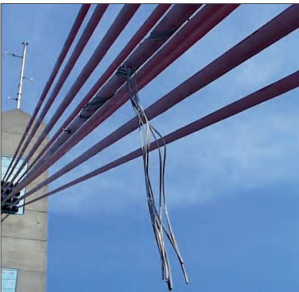
Bild 3.36: Seil nach Spleißen einzelner Drähte
