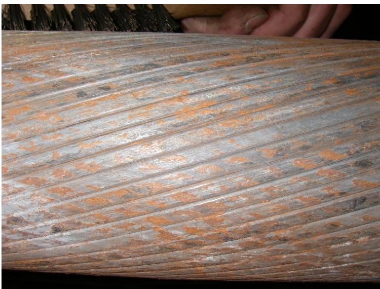
Bild 21 9. Drahtlage von Seilprobe 2 teilweise mit Drahtbürste gereinigt
