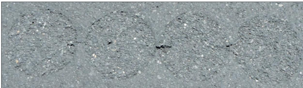
Bild 2-8: Stegbrüche zwischen den Bohrkernentnahmestellen
