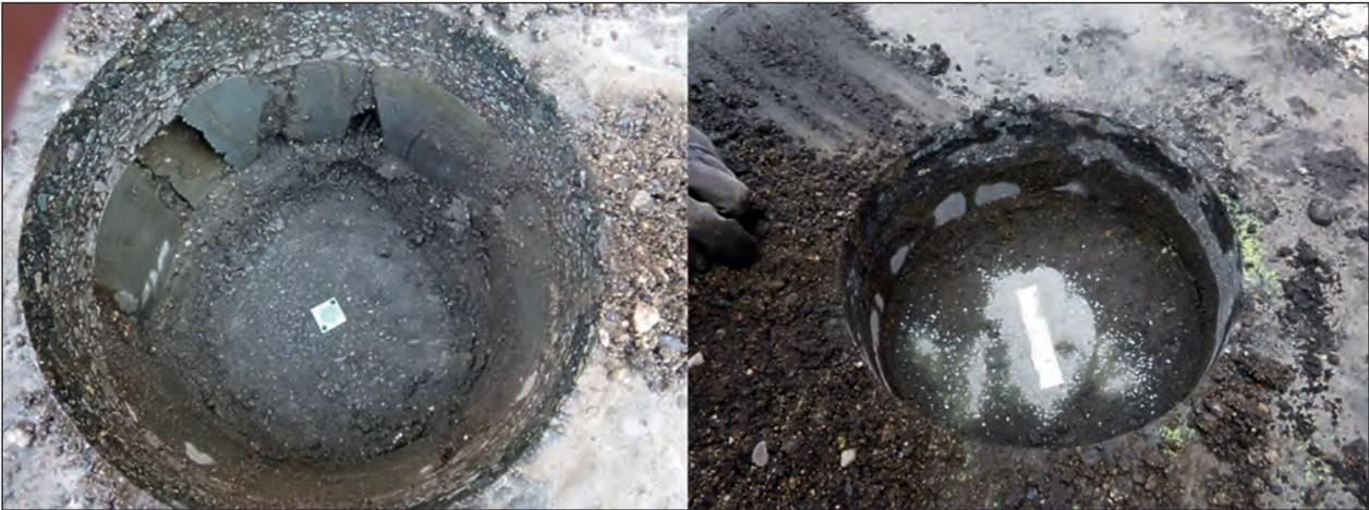
Bild 5-4: RFID-Transponder in Bohrkernentnahmestellen vor dem Verschließen
