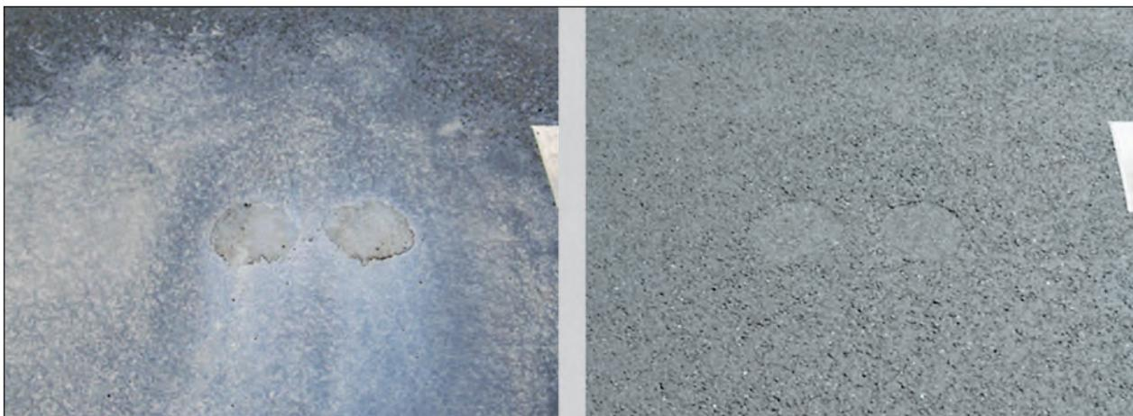
Bild 2--1: Bohrkernentnahmestelle nach Fertigstellung (links) und nach 35 Monaten (rechts)
