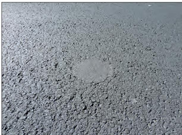
Bild 2-2: Mit Heißmischgut verschlossene Bohrkernentnahmestelle nach 3 Monaten Liegedauer
