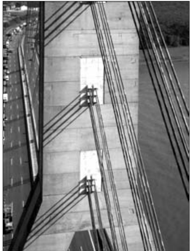
Bild 2: Rheinbrücke Flehe – Pylon und Seile
