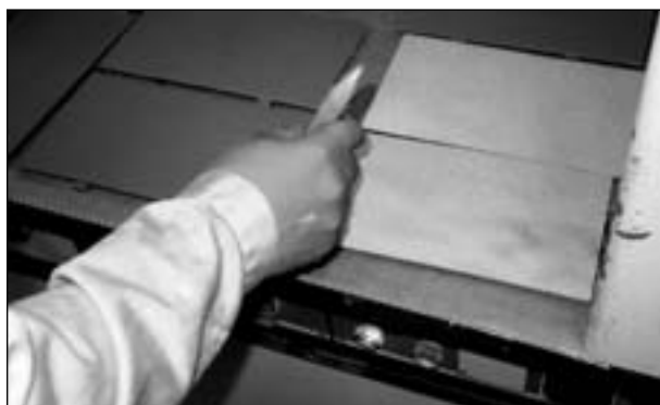
Bild 7: Applikation der Grundbeschichtung
