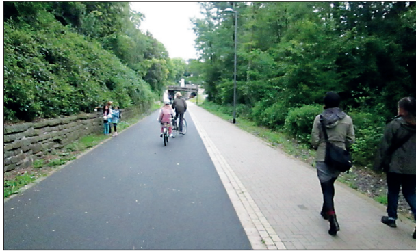
Bild 2-2: Taktile Trennstreifen als Trennung [Foto: Planungsbüro VIA eG]
