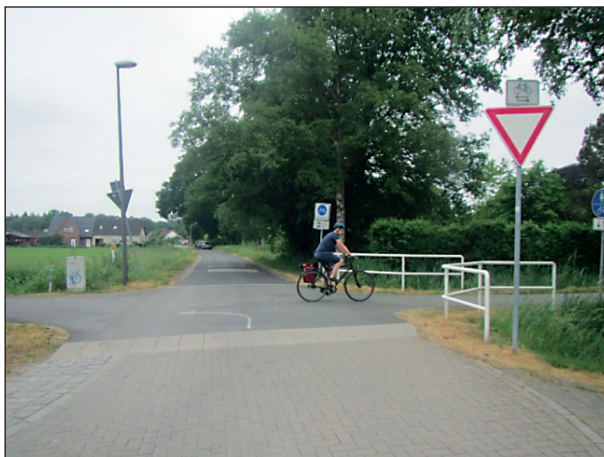
Bild 6-1: Beispiel für eine Fahrbahnanhebung [Foto: Planungsbüro VIA eG]
