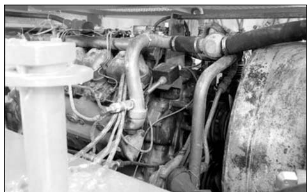
Bild 10.1: In Großmaschine eingebauter Thermofühler und Löschdüsen [90]
