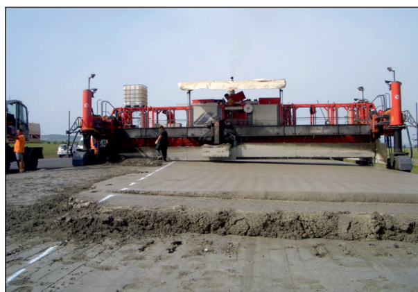
Bild 31: Schrägverwindung in Betonbauweise (LECKER 2010)
