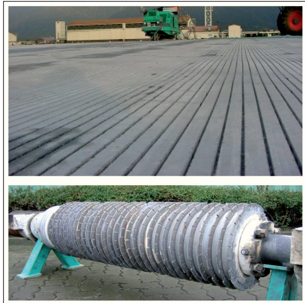
Bild 82: Grooving auf einem Flughafen (oben) und Welle zur Herstellung der Rinnen (unten) (OAT 2013)
