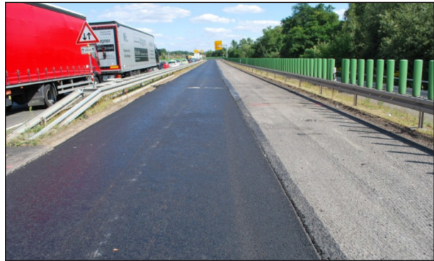
Bild 32: Einbau des AC 16 B S (SMA) in Wittenberg (B3)
