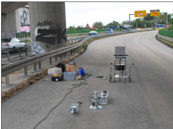
Bild 30: PVE-Tester, mod. LFGG und Impulshammer bei der Baumaßnahme „Deckschicht Wittenberg“ (D8)
