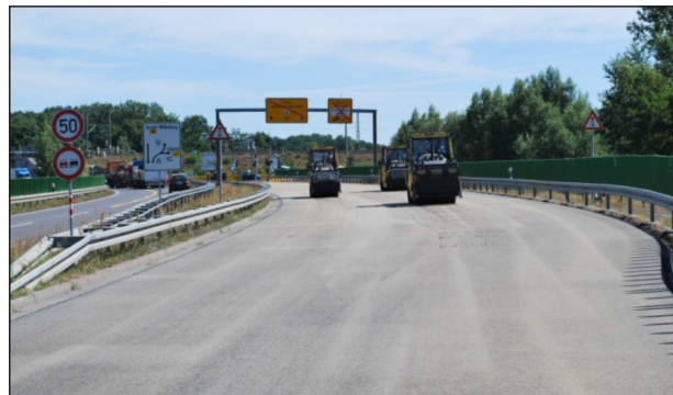
Bild 39: Einbau des SMA 11 S in Wittenberg (D8)
