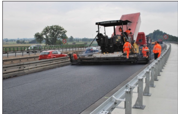
Bild 38: Einbau des PMA 5 in Düsseldorf (D7)
