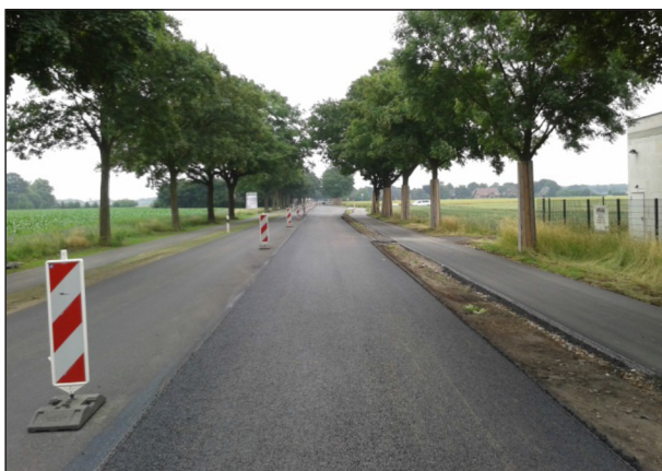
Bild 31: Einbau des AC 16 B S in Alpen (B1)
