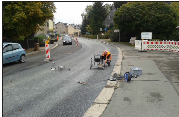
Bild 37: Einbau der SMA 8 S in Chemnitz (D6)
