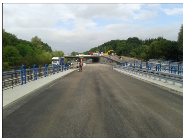
Bild 35: Einbau der SMA 8 S in Bochum, A448 (D3)
