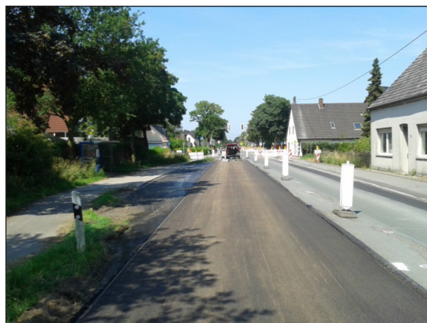
Bild 34: Einbau der Deckschicht in Alpen (D2)
