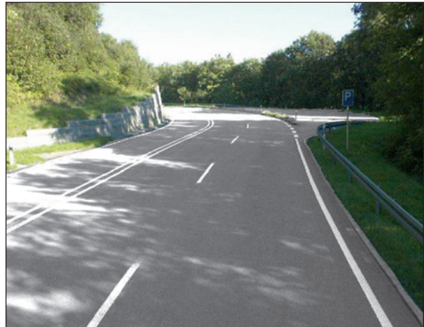
Bild 39: B 33, Station 4.950, Nachher (ZEB, 2011; Quelle: IT-ZEB Server)
