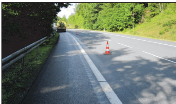
Bild 35: Rüttelstreifen neben der Fahrbahnbegrenzung
