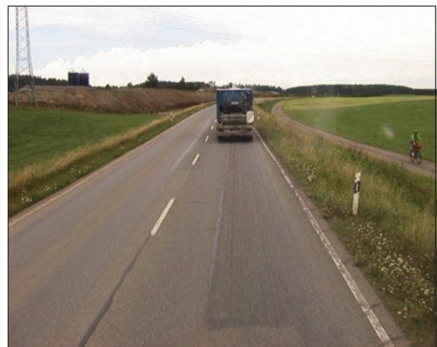
Bild 36: B 313, St. 2.900, Vorher (ZEB, 2007; Quelle: IT-ZEB Server)
