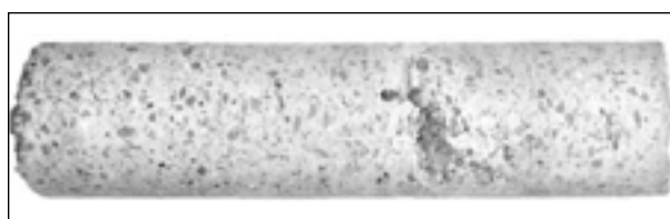
Bild 4-19: Bohrkern aus Block 5 (1. Lage Spritzbeton, 2. Lage Spritzbeton, beide mit Mattenbewehrung)
