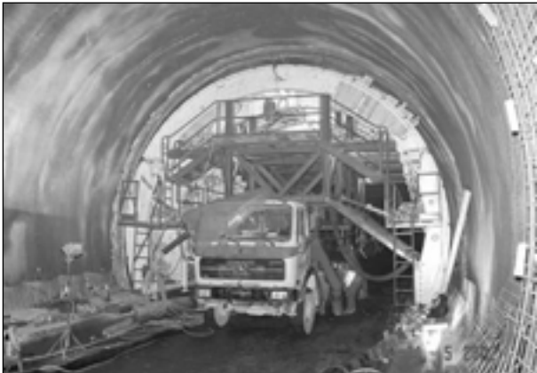
Bild 4-20: Positionierung des Schalwagens in Block 7 (2. Lage Schalbeton, unbewehrt)
