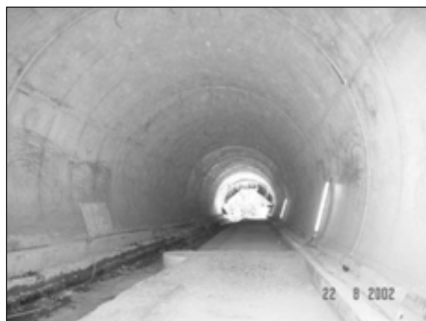
Bild 4-27: Bereich Blöcke 9 und 10 (2. Lage Schalbeton, stahlfaserbewehrt)
