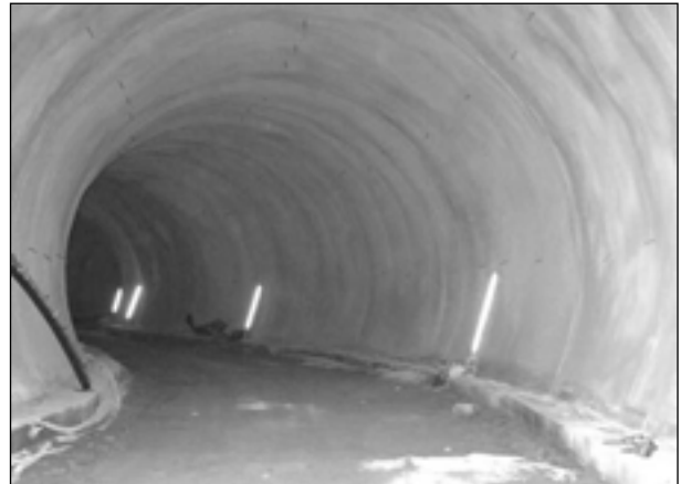
Bild 5-3: 2-schalige Spritzbetonkonstruktion im Zuluftstollen des Rennsteigtunnels (BAB A71)
