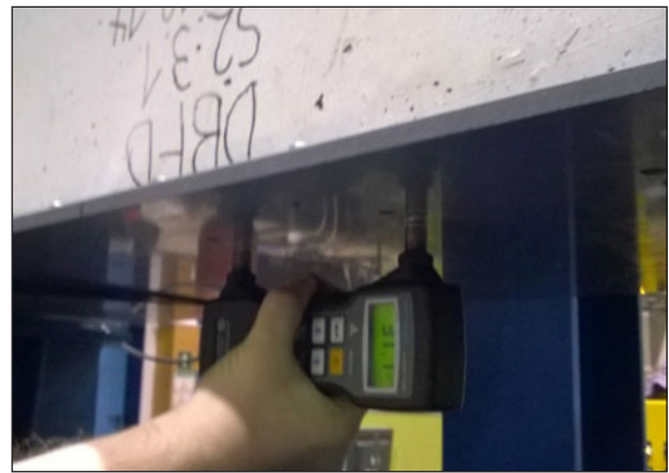
Bild 29: Ultraschalllaufzeitmessungen (Serie 2) im Zugbereich an der Unterseite der Verbundbalken
