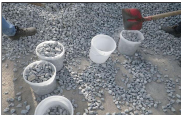
Bild 4: Probenahme der Ausgangsstoffe am Einbautag
