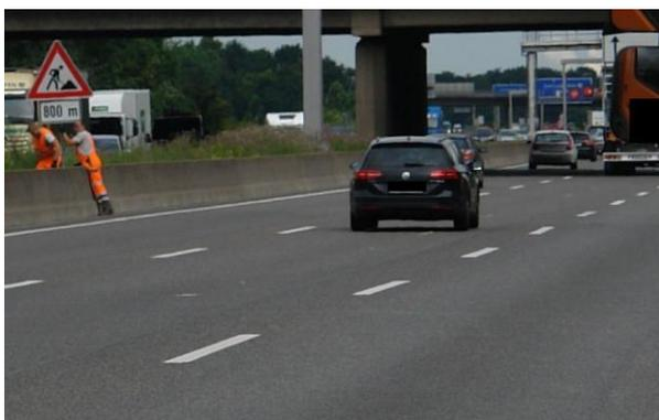
**Bild 6:** Aufstellen eines Schildes im Mittelstreifen
