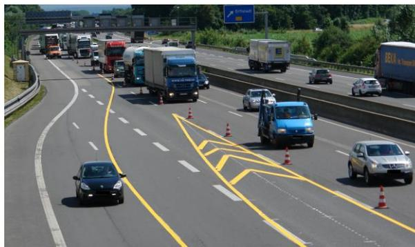
**Bild 10:** Missachtung der Längsabspernung durch Leitkegel
