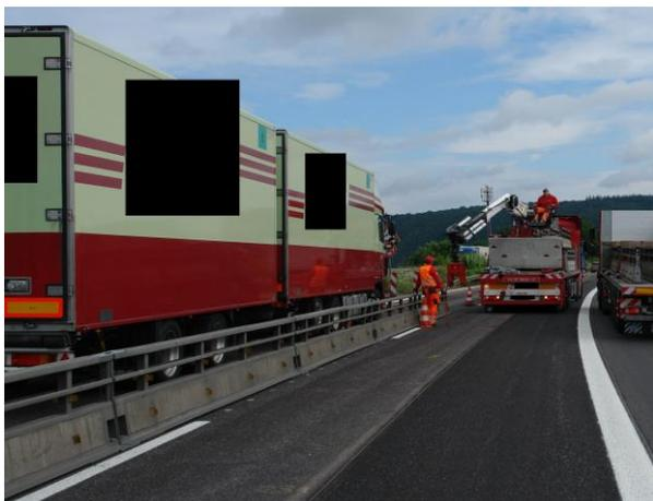
**Bild 7:** Abbau einer Stahlschutzwand unmittelbar neben dem fließenden Verkehr
