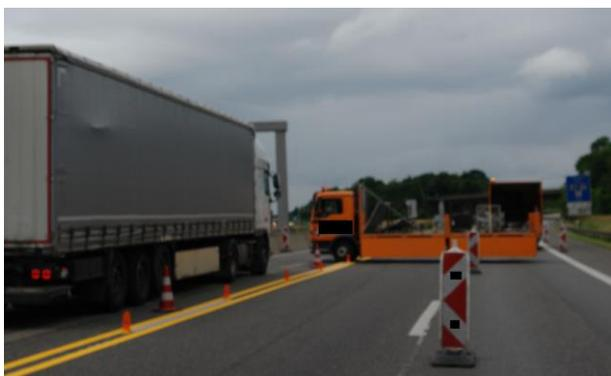
**Bild 8:** Baustellenfahrzeug wendet unter Mitbenutzung der Fahrbahn
