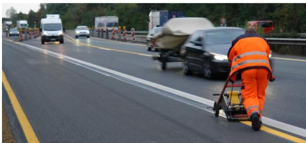
**Bild 5:** Verlegen einer Gelbmarkierung unmittelbar neben dem fließenden Verkehr
