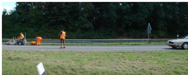
**Bild 9:** Kurzzeitige Vollsperrung einer Einfahrt zum Verlegen einer Gelbmarkierung
