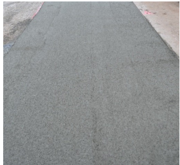
Bild 5.5-60: Nahtflanke des COPS mit Fasern (oben links), Detailaufnahme einer frischen COPS-Oberfläche (oben rechts). Unten: Hergestellte COPS-Schichten
