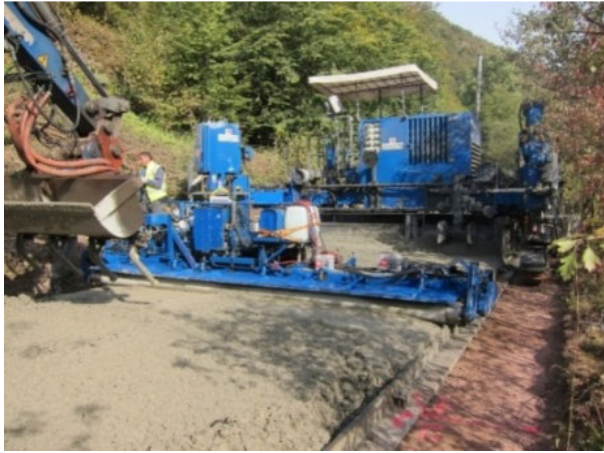
Bild 5.5-41: Einbau von Unterbeton (links) und Oberbeton (rechts)
