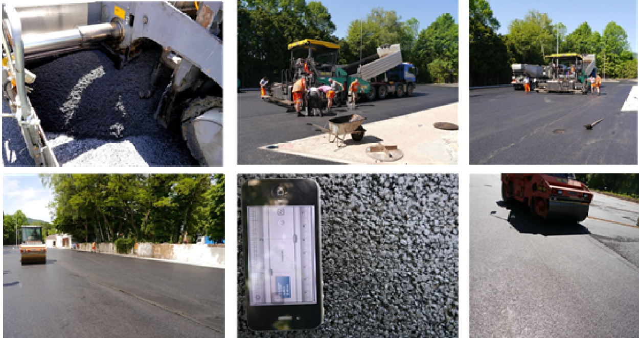
Bild 5.2-26: Weitere Bilder, die den Einbau der zwei Asphaltbeläge zeigen (Quelle: Max Aicher Umwelt)
