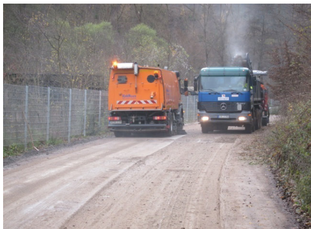
Bild 5.5-57: Vorbereiten der Einbaufäche (links), gefräster Unterbeton (rechts)
