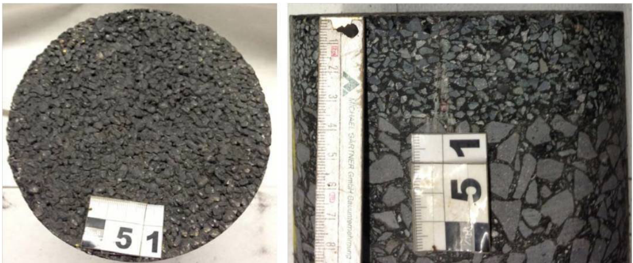
Bild 5.3-68: Beschaffenheit der Asphaltdeckschicht PMA 5 des Bohrkerns BK11 (im Bild 51) bei einem Hohlraumgehalt von 4,9 Vol.-%
