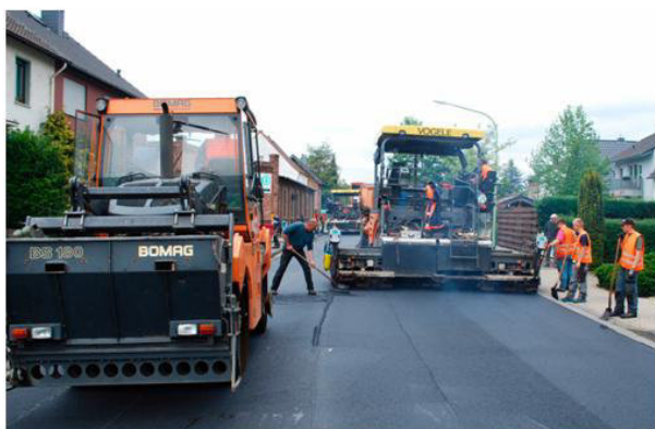
Bild 5.3-76: Bau der Erprobungsstrecke LOA 5 D in Düren
