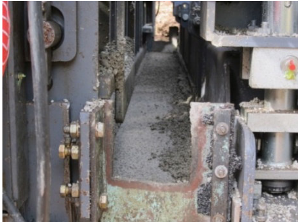
Bild 5.5-42: COPS vor dem Querglätter (links), Herstellung eines Waschbetons (rechts); Einbaurichtung nach links
