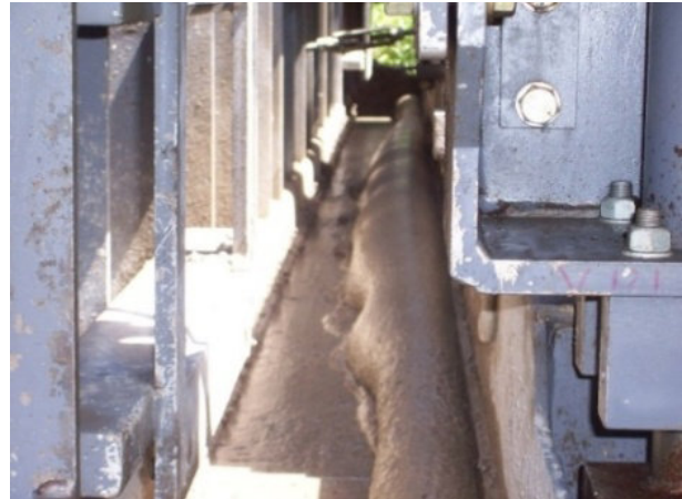
Bild 5.5-42: COPS vor dem Querglätter (links), Herstellung eines Waschbetons (rechts); Einbaurichtung nach links
