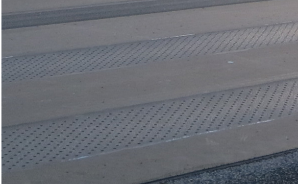
Bild 3.2-45: Detailaufnahme der Oberfläche des fertiggestellten Lochfelds
