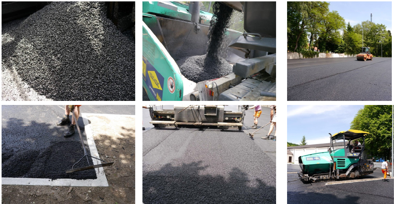
Bild 5.2-25: Aufnahmen während des Einbaus der zwei Asphaltbeläge SMA 5 S und PA 8 – linke Hälfte (Blick nach Süden) PA 8 und rechte Hälfte SMA 5 S (Quelle: Max Aicher Umwelt)
