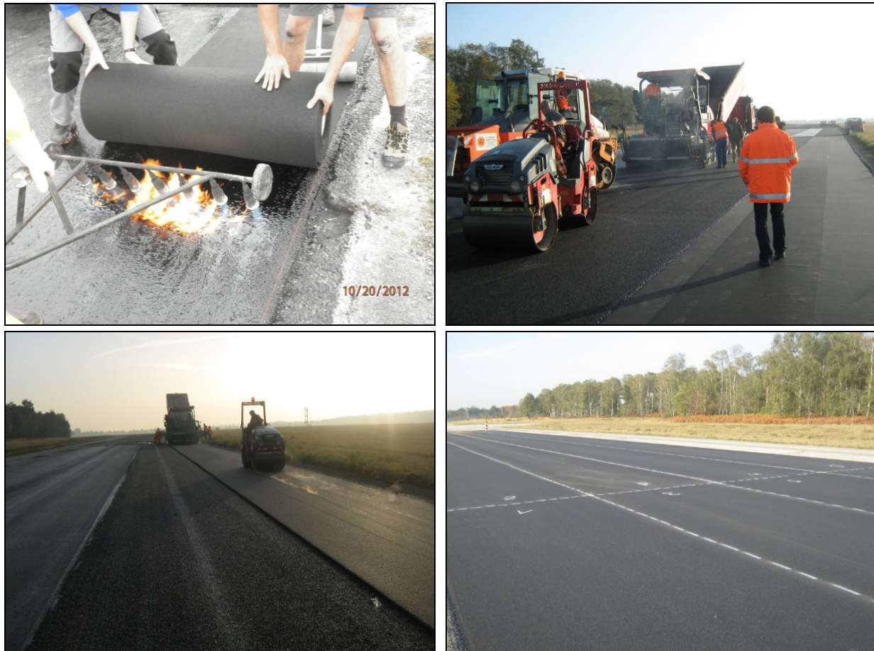
Bild 5.4-29: Einbau der Erprobungsfelder – NATO Air Base Geilenkirchen
