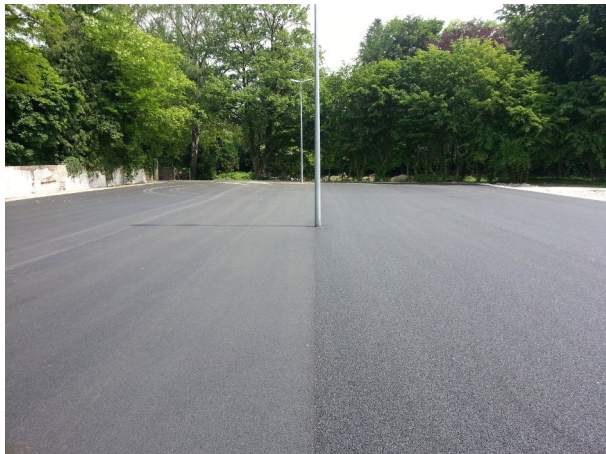
Bild 5.2-37: Fertig eingebaute Fahrbahndeckschichten mit EOS auf dem Parkplatz der Annahütte bei Freilassing; die linke Hälfte der Fläche ist mit SMA 5 versehen, die rechte mit PA 8.
