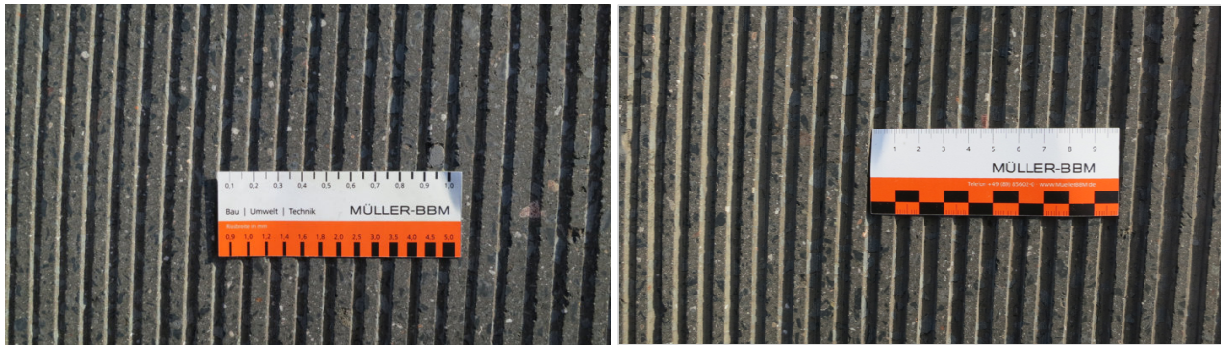
Bild 3.2-42: Oberflächenbilder der tatsächlich ausgeführten Längsrillenfelder. Links: nom. Rillenbreite 2 mm, nom. Rillenabstand 10 mm; rechts: nom. Rillenbreite 4 mm, nom. Rillenabstand 8 mm
