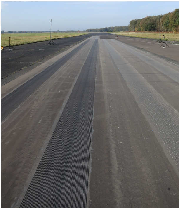
Bild 3.2-46: Oberflächen des fertiggestellten Längsrillenfelds LS5 (links) und des fertiggestellten Lochfelds (rechts)
