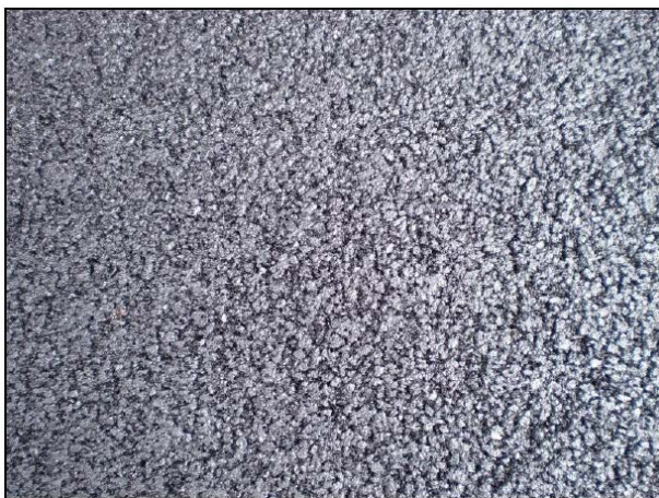
Abbildung 4-67: Oberfläche des SMA 8 Hmb. mit R8 nach Vorverdichtung mittels Straßenfertiger.
