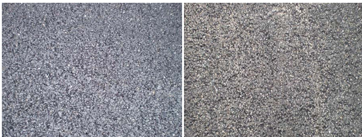
Abbildung 4-58: Oberfläche des SMA 8 Hmb. als Nullvariante nach der abgeschlossenen Walzverdichtung.
