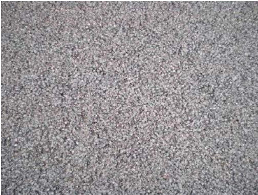
Abbildung 4-53: Oberfläche des Verzögerungsstreifens (SMA 8 Hmb. mit R1) nach der Abstreuerung mit Splitt.
