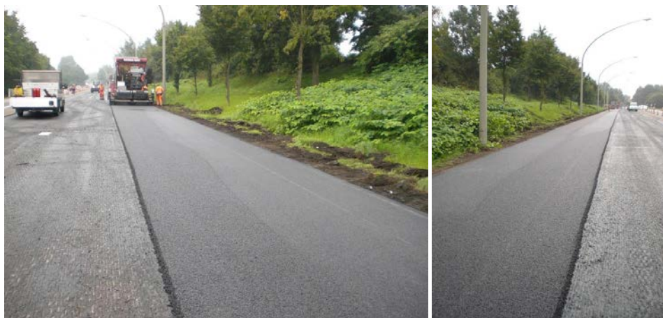
Abbildung 4-51: Einbau des Verzögerungstreifens mit SMA 8 Hmb. mit R1.
