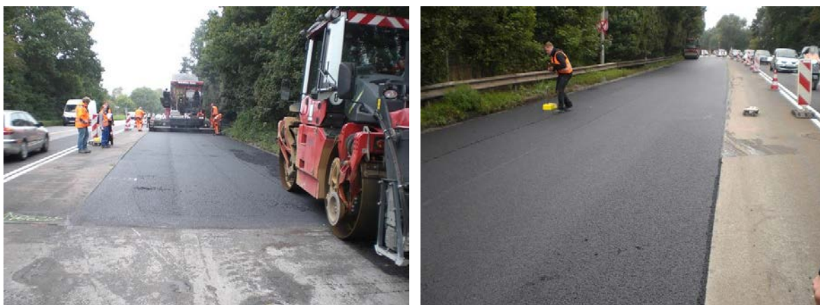
Abbildung 4-56: Einbau der Variante SMA 8 Hmb. mit 10 % Asphaltgranulat / ohne Rejuvenator.
