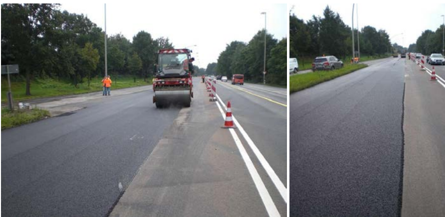
Abbildung 4-62: Einbau des Übergangsbereiches SMA 8 Hmb. mit dem Rejuvenator R1 und R8.
