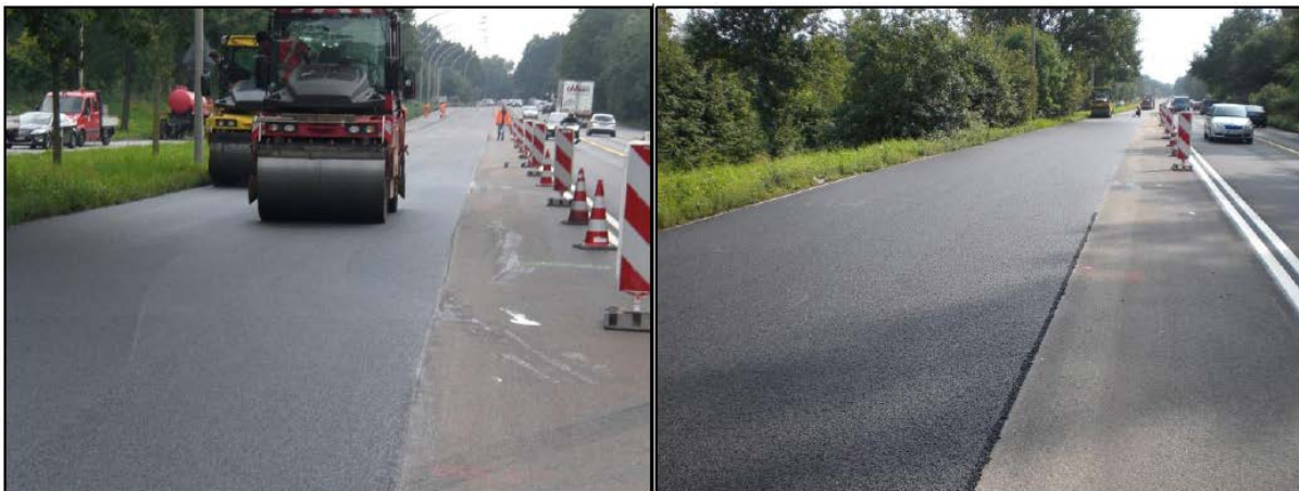
Abbildung 4-66: Einbau des SMA 8 Hmb. mit R8.
