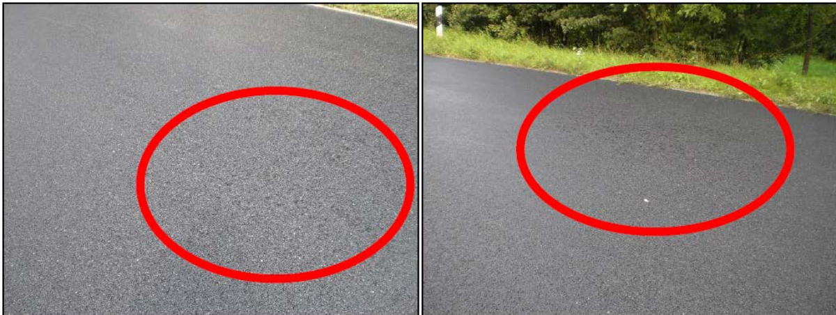
Abbildung 4-69: Kleinere Fettflecken an der Oberfläche des SMA 8 Hmb. mit R8.
