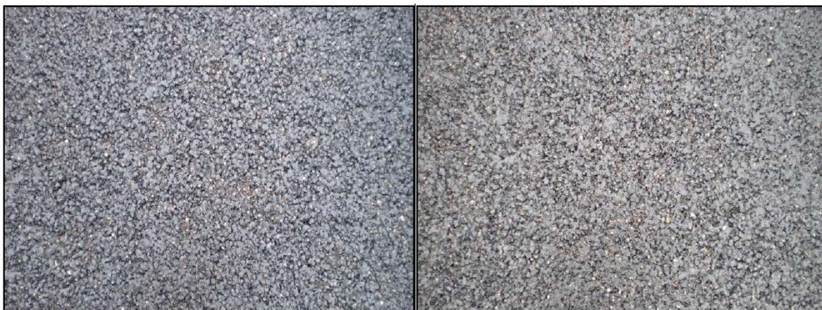
Abbildung 4-63: Oberfläche des SMA 8 S Hmb. mit R1 nach der abgeschlossenen Walzverdichtung und Abstreuerung.
