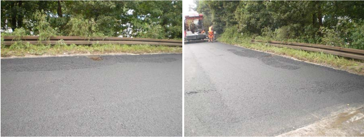
Abbildung 4-57: Im Randbereich wurde Mischgut per Hand nachgeworfen.
