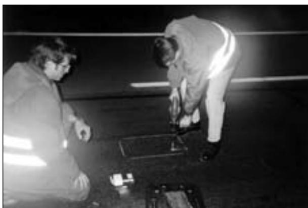
**Bild 15:** Montage des Magnetfelddetektors
