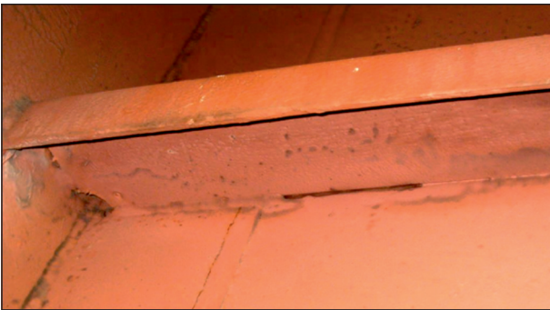
Bild 72: Innenansicht Hauptträgersteg mit Beulsteifen
