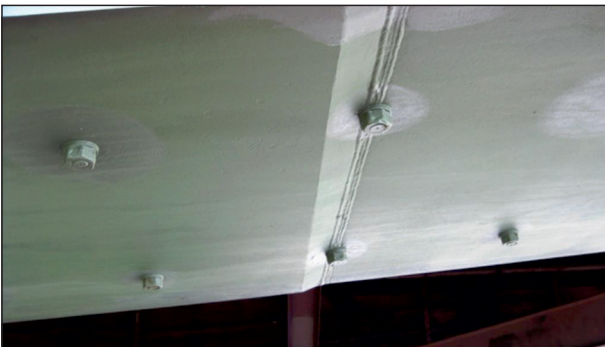
Bild 74: Blechdickenabstufung Hauptträgeruntergurt
