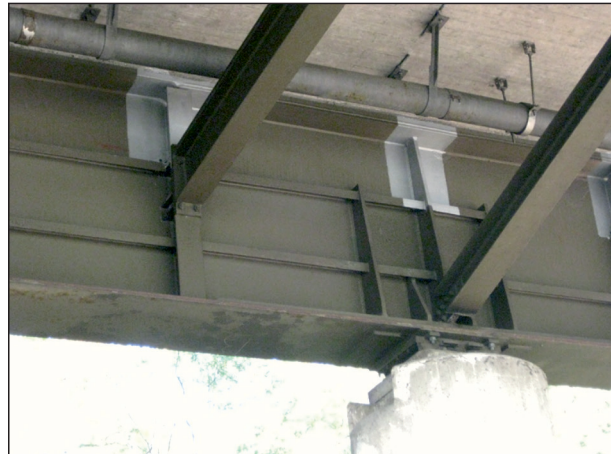
Bild 67: Innenansicht Hauptträgersteg mit Querträgeranschluss
