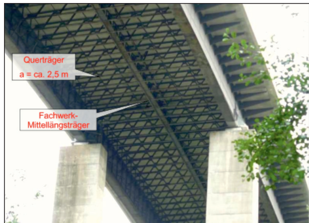
Bild 46: Untersicht Talbrücke
