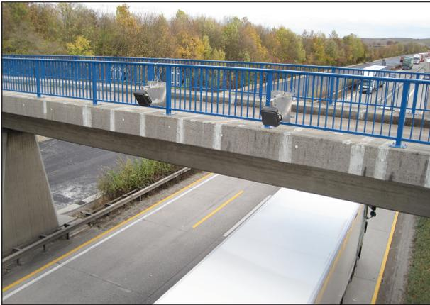
Bild 33: Radarsensoren über der Fahrbahn
