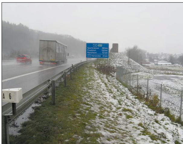
Bild 3-1: Standort BAB A 6 Sinsheim Steinsfurt, km 611,2 Fahrtrichtung Mannheim
