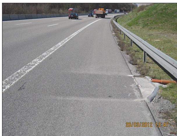
Bild 5-4: Standort Steinsfurt BAB A 6 – ausgewaschenes Feinpartikelzwischen depot
