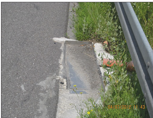
Bild 5-1: Standort Steinsfurt BAB A 6 – die Voredimentation am Bankett fand weitgehend vollständig für das Grobkorn (Sand+Kies) statt
