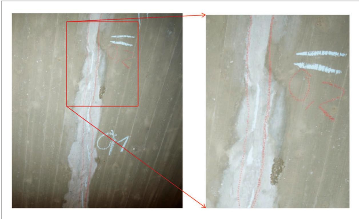
**Bild 56:** Hohlkasten – Aufgrund von Staubentwicklung sind kaum Befunde erkennbar. Bsp. Hohlkastendecke, Höhe etwa 6,0 m, Längsriss 0,1 bis 0,2 mm Breite ist nicht feststellbar, Quelle: TÜV Rheinland
