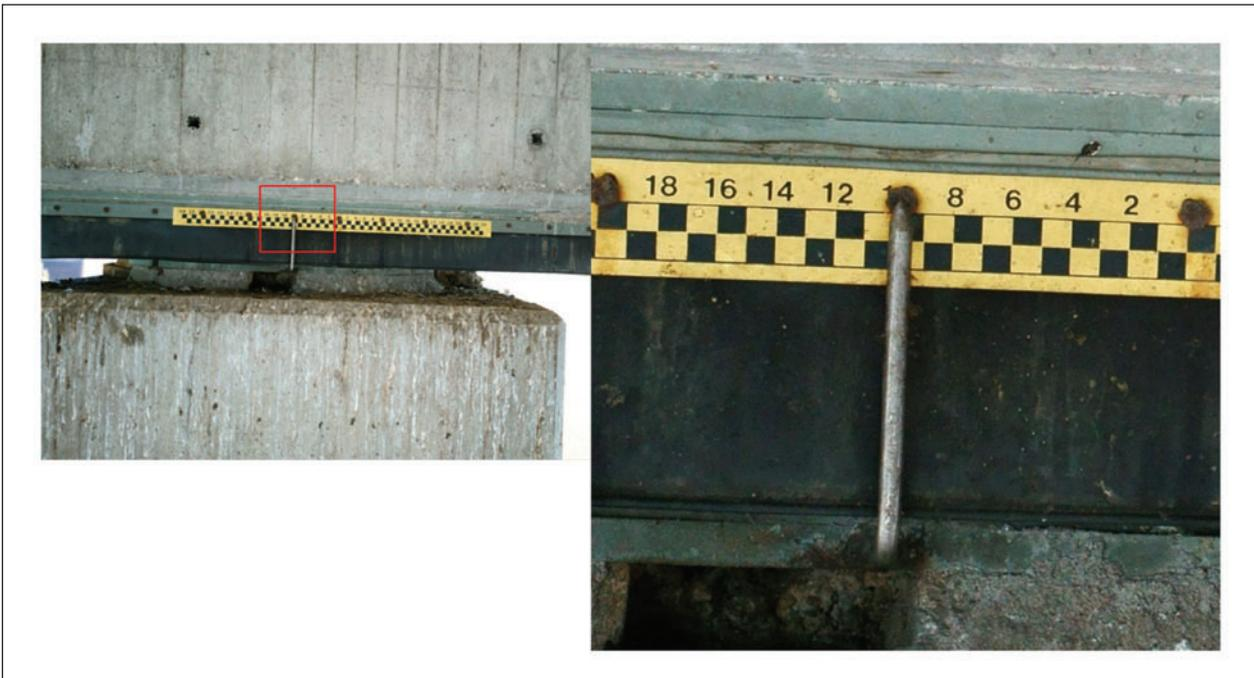
**Bild 49:** Pfeiler und Lager – Lagerstands-Anzeigen sind ablesbar. Aufgrund von Schutzvorrichtungen ist das Lager nicht einsehbar, Quelle: TÜV Rheinland
