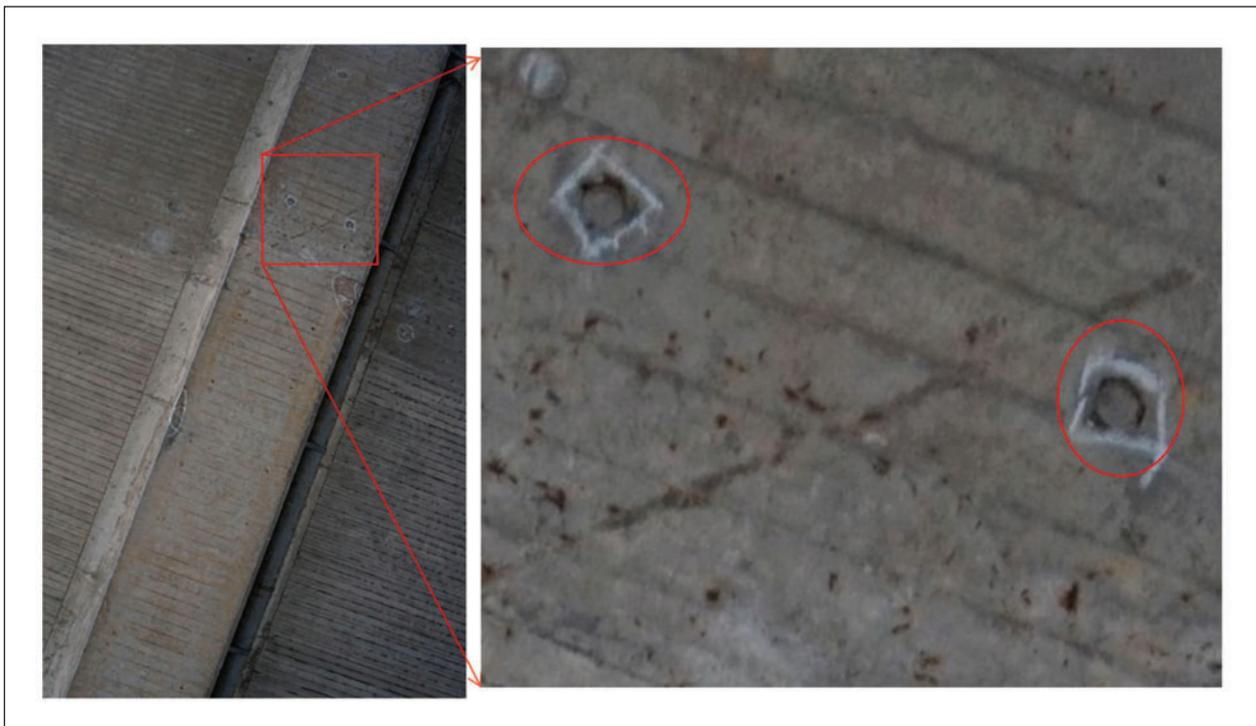
**Bild 53:** Überbau Plattenbalken – Fremdkörper an der Betonoberfläche, Quelle: TÜV Rheinland
