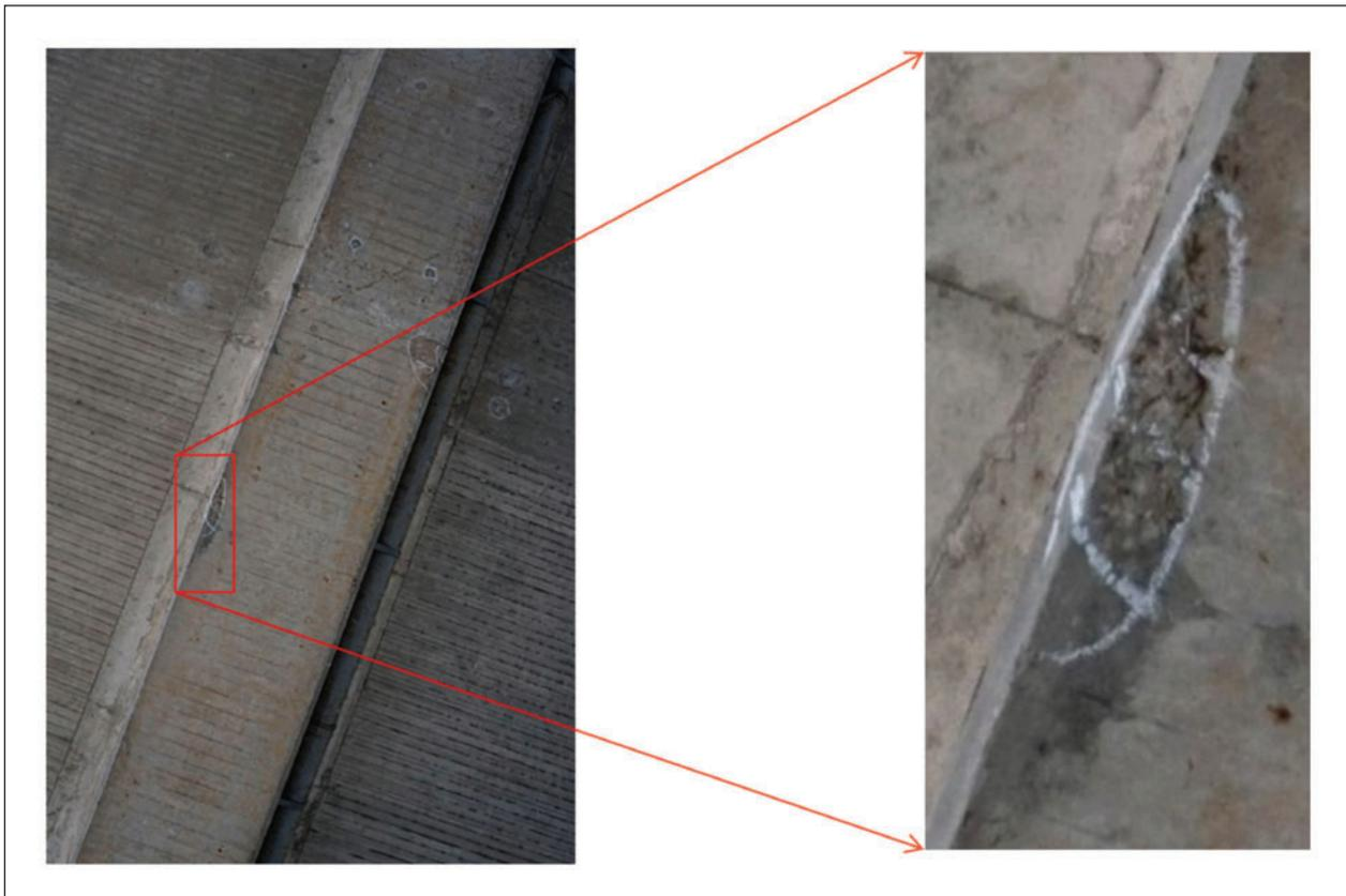
**Bild 52:** Überbau Plattenbalken – Kleine Betonabplatzung im Kantenbereich, Quelle: TÜV Rheinland
