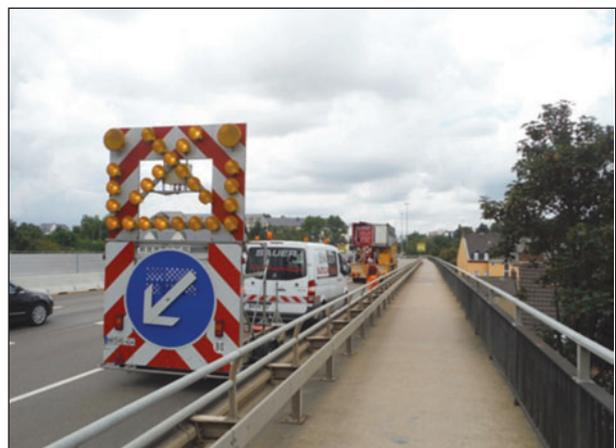
**Bild 59:** Verkehrssicherung für das Besichtigungsgerät auf der Europabrücke. Eine von 4 Richtungsfahrbahnen wird für die Dauer des Geräteeinsatzes gesperrt, Quelle: TÜV Rheinland
