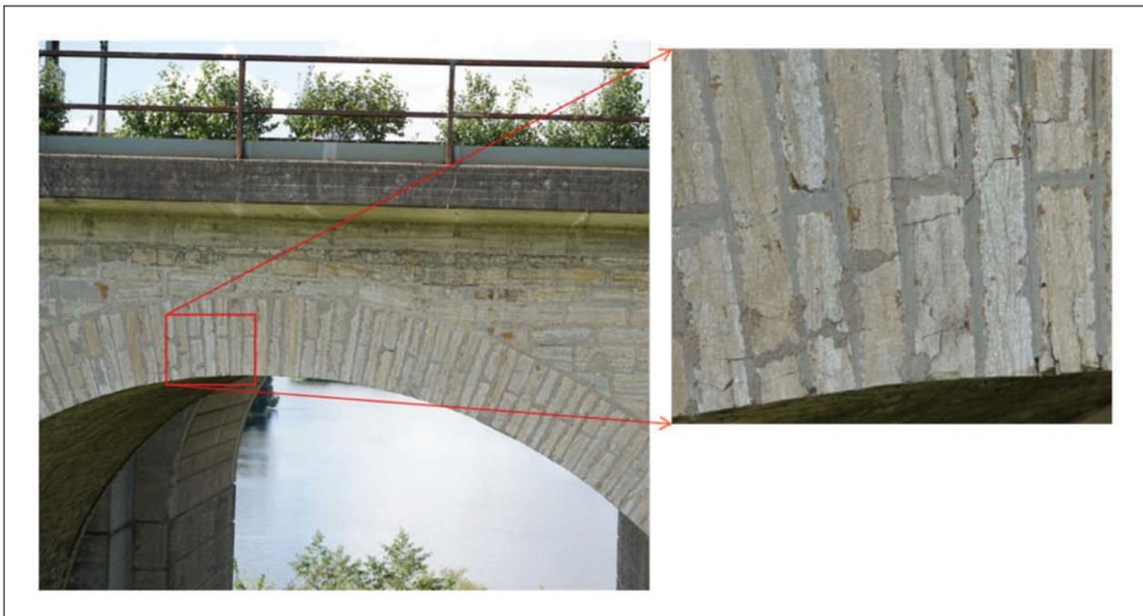
**Bild 24:** Bogen, Scheitel, Stirnseite – Risse durch Steine und Mauerwerksfugen, Quelle: TÜV Rheinland
