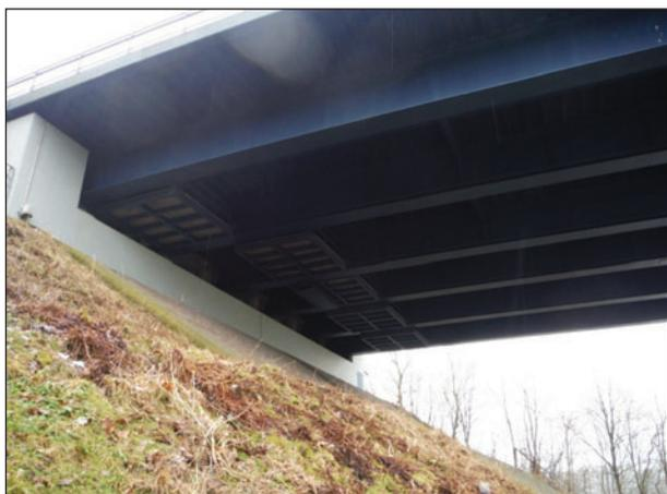
**Bild 60:** Am Bauwerk fest installierte Befahranlage, bzw. Arbeitsbühnen zwischen den Haupt-/Längsträgern, Quelle: TÜV Rheinland
