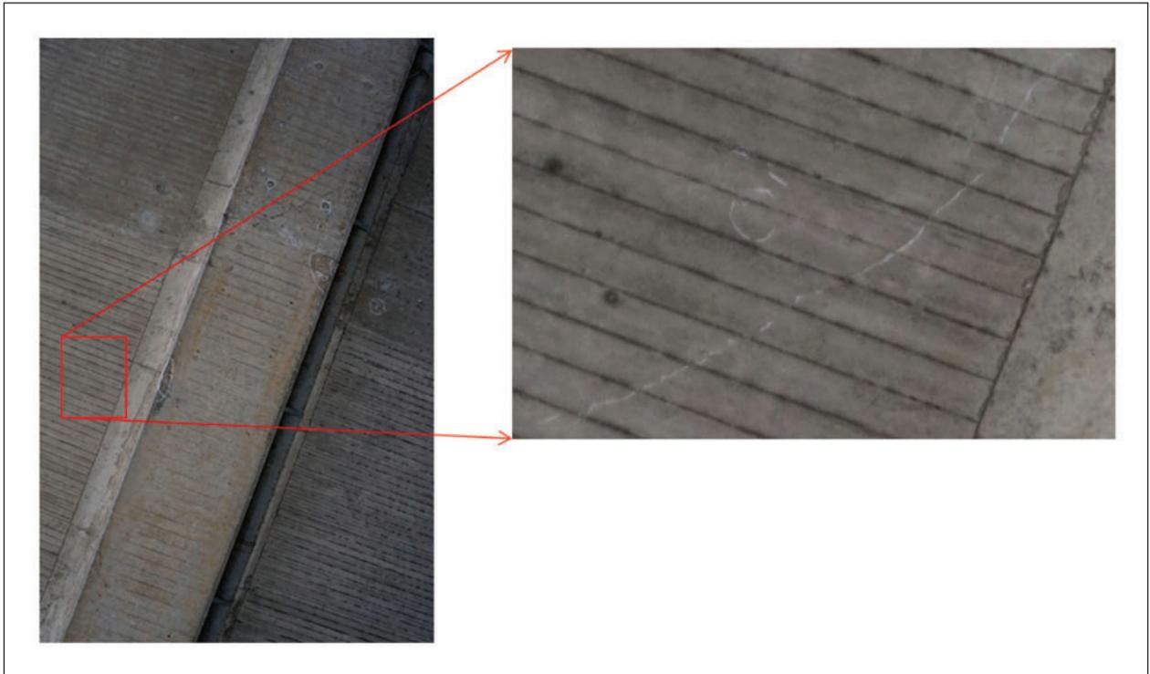
**Bild 54:** Überbau Plattenbalken – Mechanische Beschädigung/Kratzer an der Platten-Unterseite, Quelle: TÜV Rheinland
