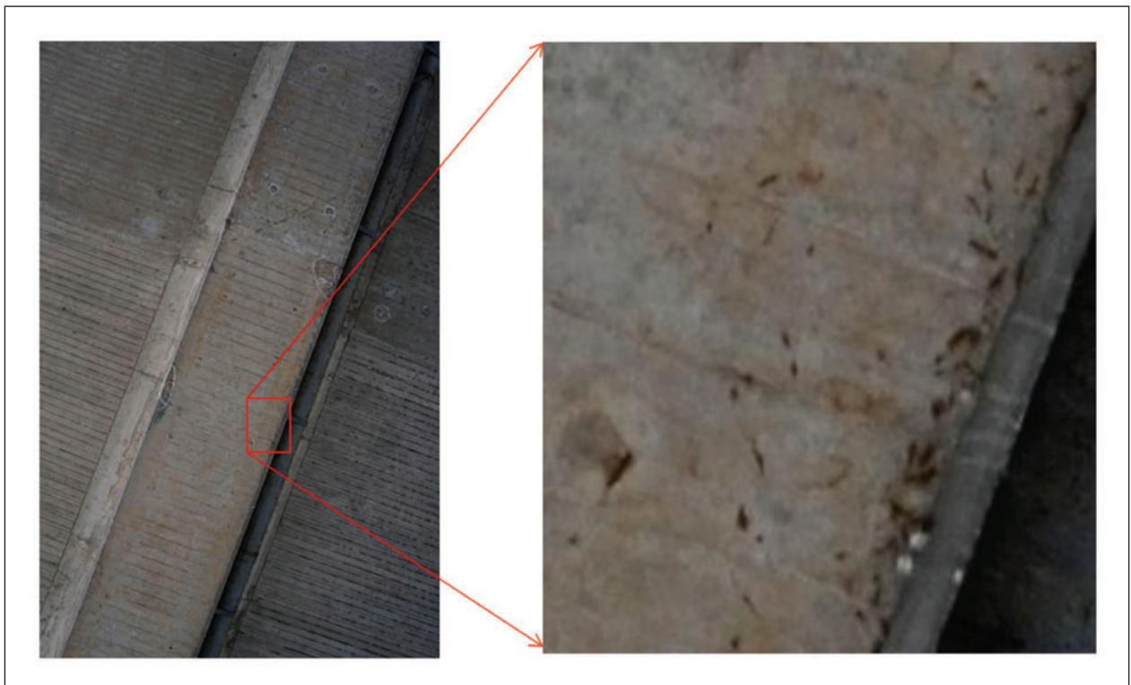
**Bild 51:** Überbau Plattenbalken – Unterseite Längsbalken, Bindedrahtreste mit Korrosion an der Betonoberfläche, Quelle: TÜV Rheinland
