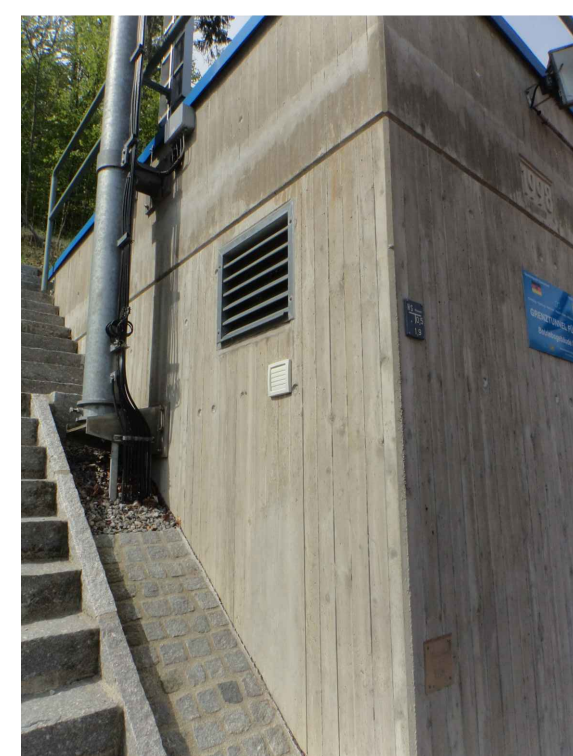
Seitenansicht Tunnelbetriebsgebäude - Durchführung der Rohrleitungen angedacht.
