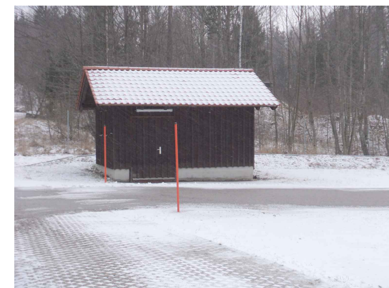
Schuppen ggf. Unterbringung der Steuerungstechnik möglich
