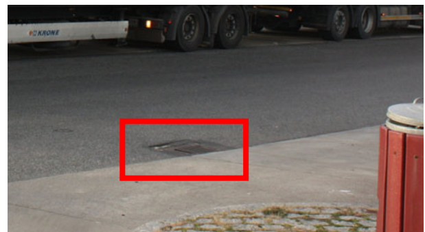
Bild 84: Wasserablauf vor einer Zwischeninsel
