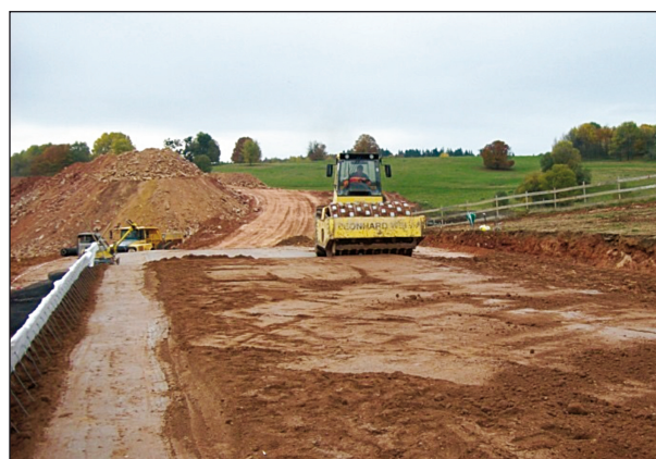
Bild 231: Verdichtung der ersten Lage
