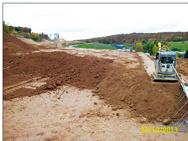
Bild 232: Aufbringen der zweiten Lage
