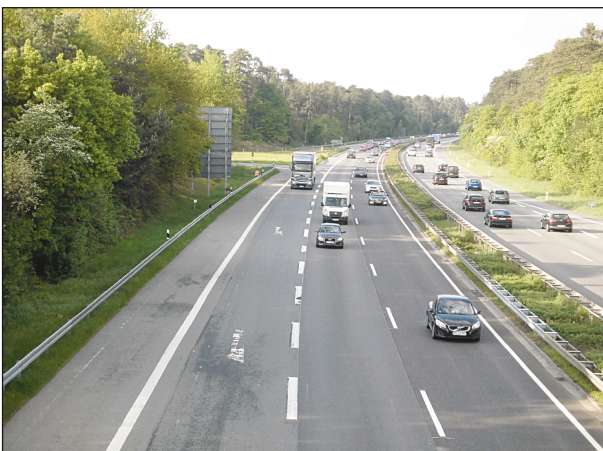
Bild 64: Einfahrt in Rüsselsheim-Ost FR Süd (eigenes Foto)
