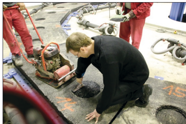
Bild 40: Einbau der Sanierungsmaterialien
