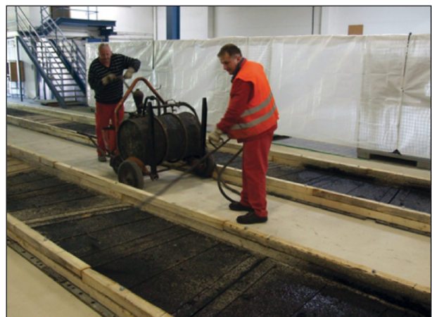
Bild 34: Vorbehandlung der Trägerplatten
