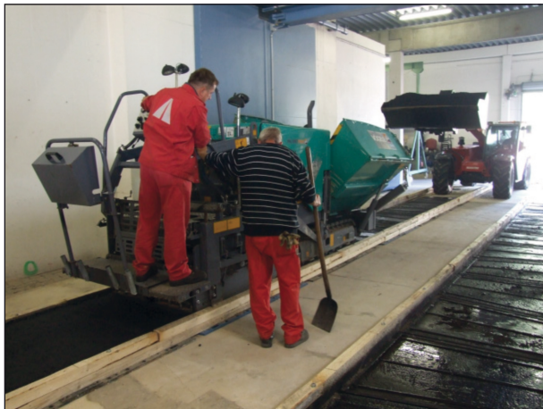
Bild 35: Einbau der Binderschicht
