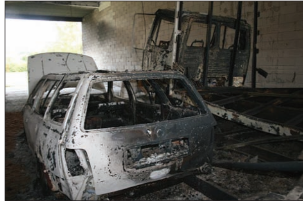
Bild 4: Zustand der Fahrzeuge nach dem Brand
