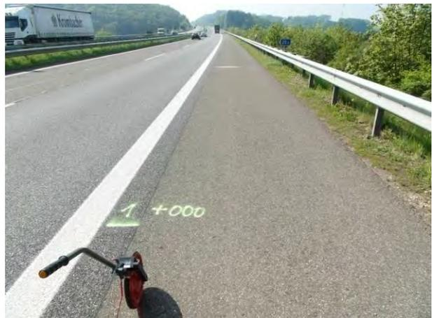
**Abbildung 58:** Erneuerung der Asphaltdeckschicht im Hauptfahrstreifen
