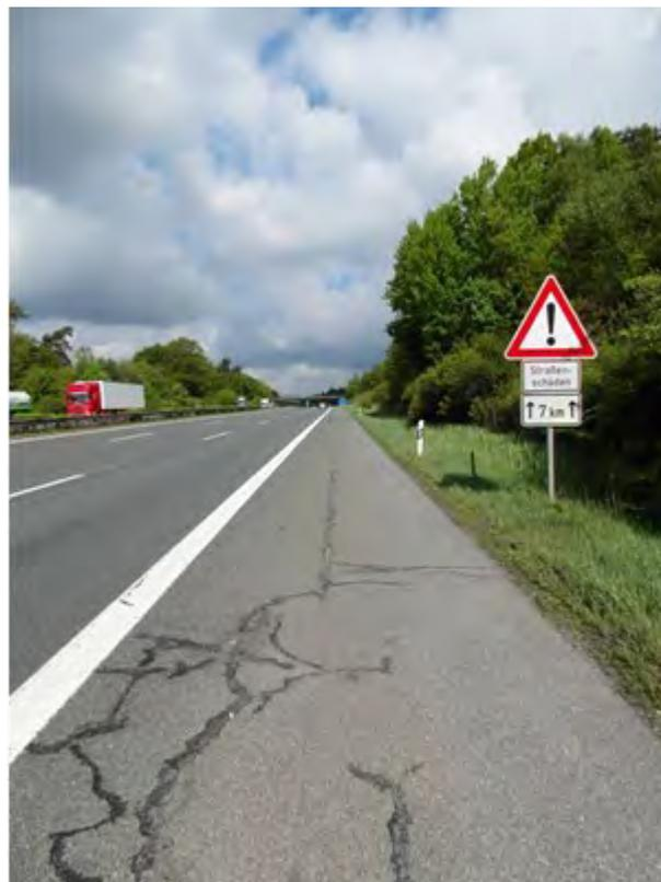
**Abbildung 71:** Beispielhafte Darstellung des sanierten Hauptfahrstreifens und der verbliebenen Risse im Seitenstreifen
