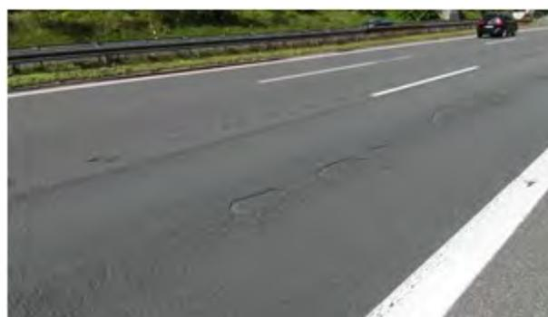
**Abbildung 72:** Beispielhafte Darstellung Ausbrüchen in der Asphaltdeckschicht
