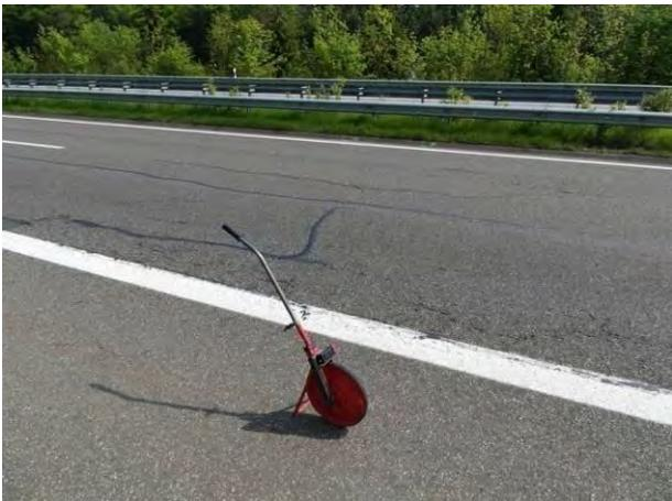
**Abbildung 55:** Risse in der Asphaltdeckschicht (teilweise vergossene Einzelrisse)
