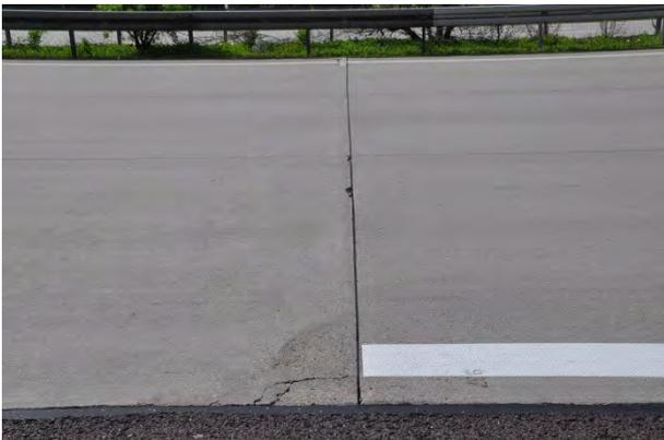
**Abbildung 50:** Kantenschäden und Eckabbruch
