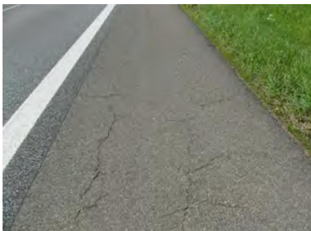
**Abbildung 70:** Beispielhafte Darstellung des sanierten Hauptfahrstreifens und der verbliebenen Risse im Seitenstreifen
