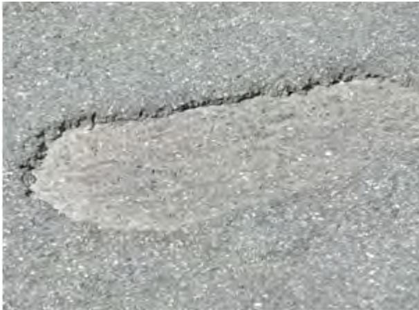
**Abbildung 73:** Beispielhafte Darstellung Ausbrüchen in der Asphaltdeckschicht
