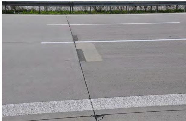
**Abbildung 53:** Tagesansatz mit Kantenschäden und Eckabbruch
