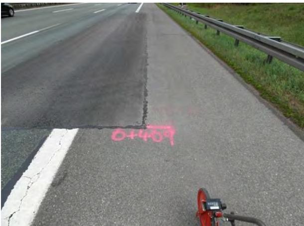
**Abbildung 56:** Flickstellen in der Asphaltdeckschicht
