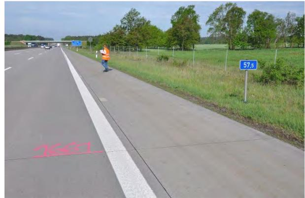
**Abbildung 22:** Plattengenaue Markierung auf der Fahrbahn an der Stationierungstafel
