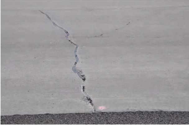
**Abbildung 49:** Durchgehender Querriss mit Ausbrüchen und Schrägriss
