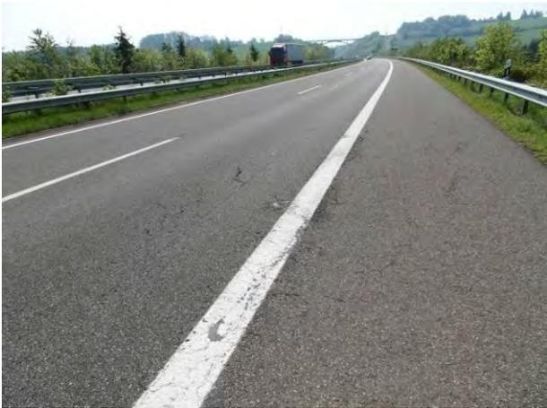
**Abbildung 54:** Risse in der Asphaltdeckschicht (unvergossene Einzel- und Netze)
