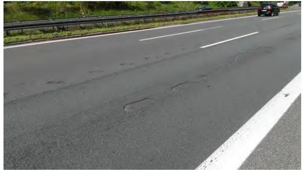
**Abbildung 57:** Ausbrüche in der Asphaltdeckschicht
