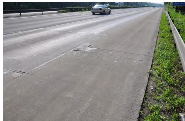
**Abbildung 69:** Plattenersatz im ersten Fahrstreifen
