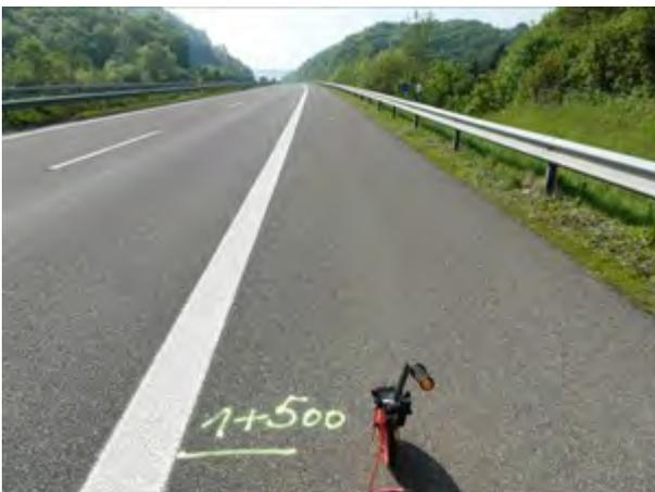
**Abbildung 26:** Anbringen von Stationierungsmarkierungen aller 500m
