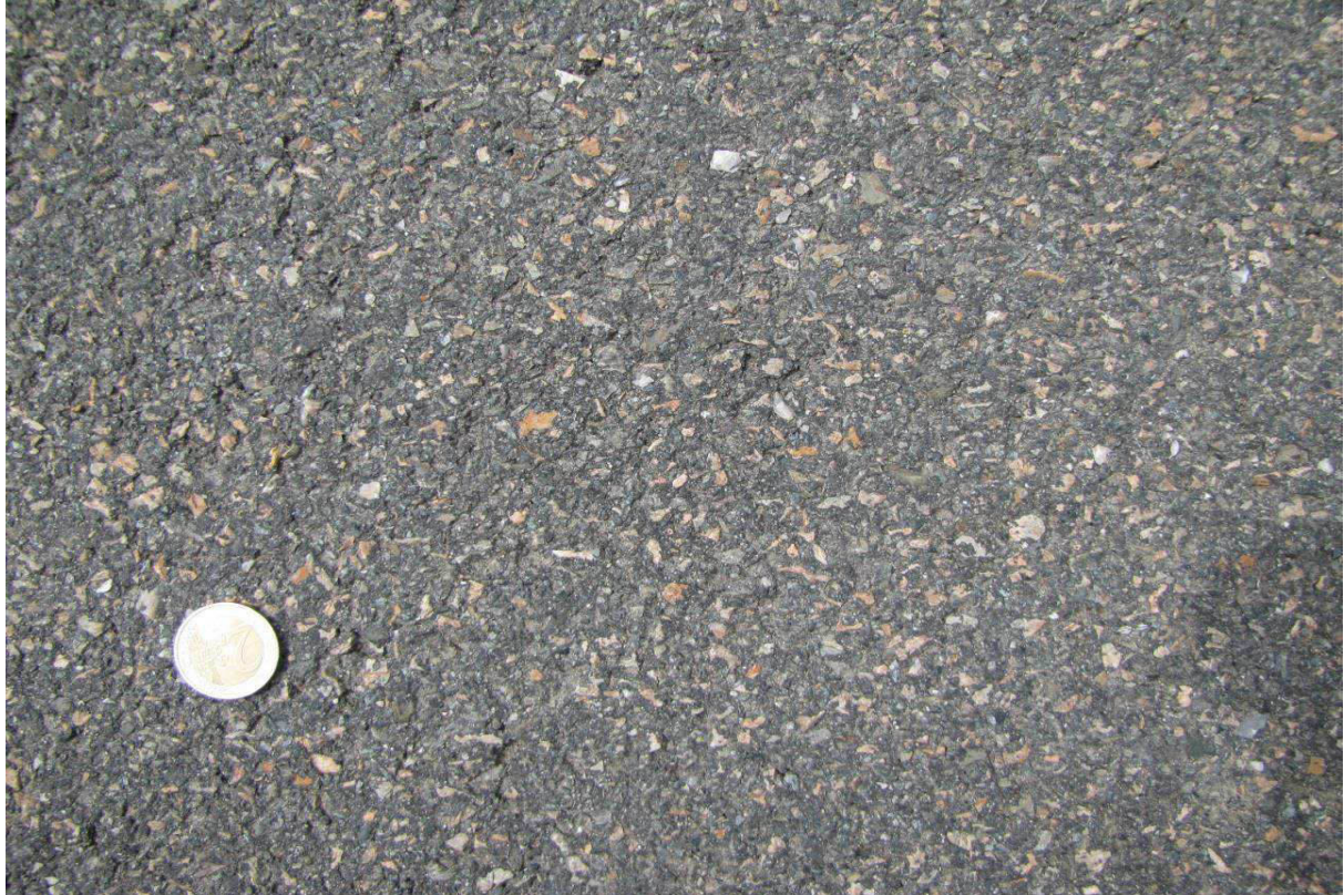
Detailaufnahme der Deckschicht:
