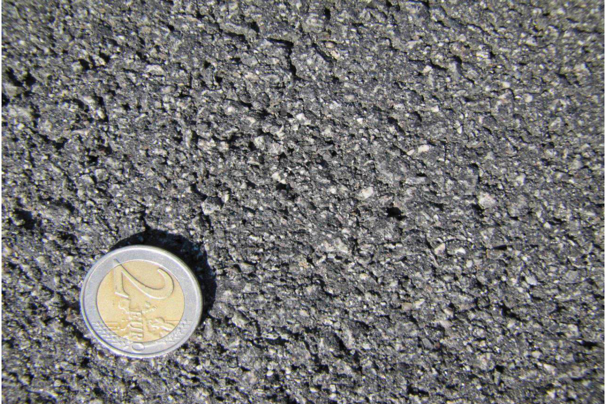
Detailaufnahme der Deckschicht:
