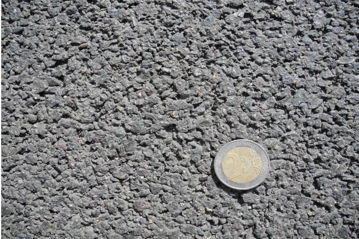
Detailaufnahme der Deckschicht:
