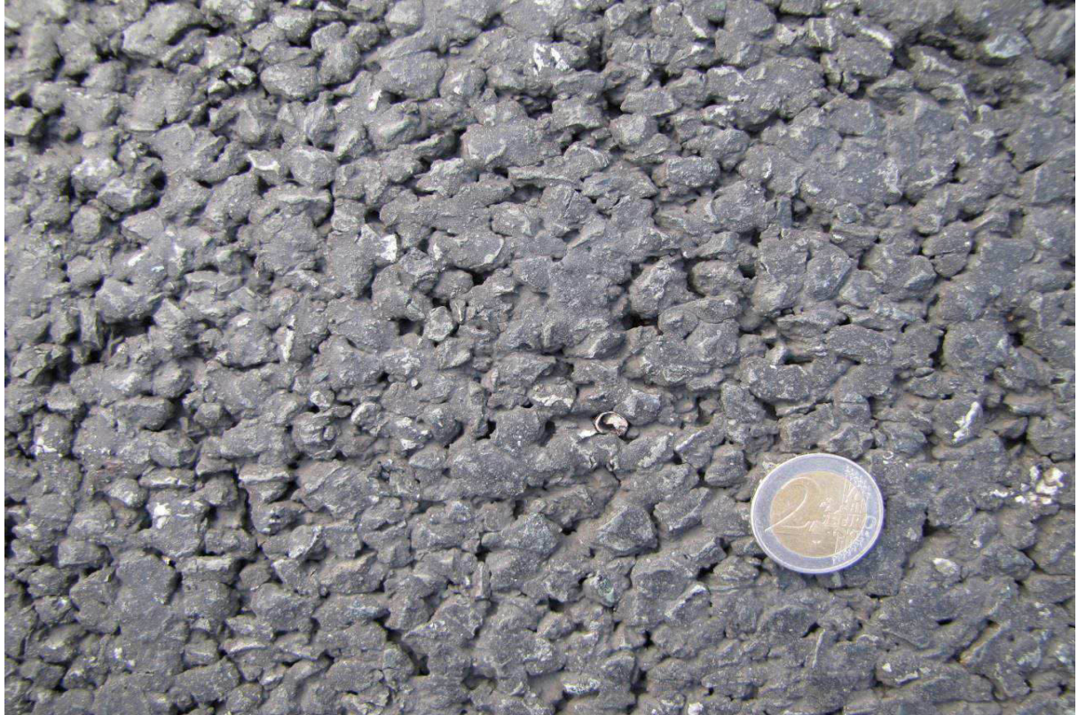
Detailaufnahme der Deckschicht:
