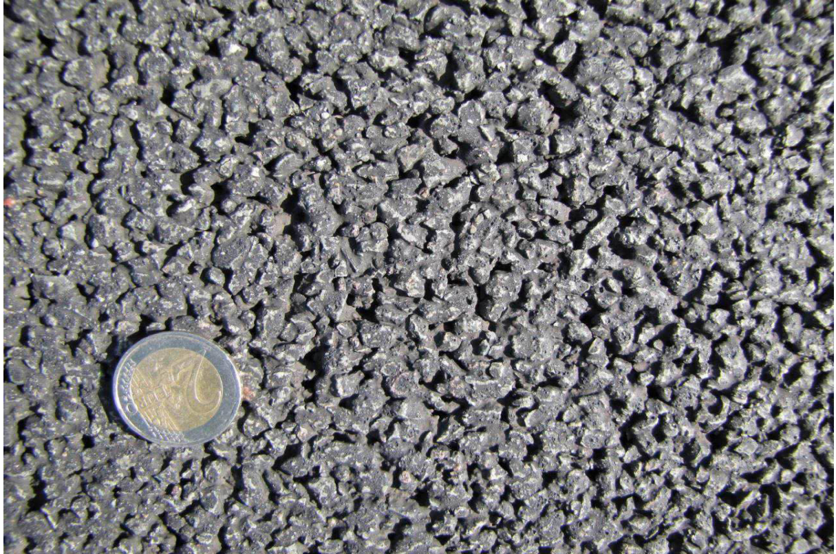
Detailaufnahme der Deckschicht:
