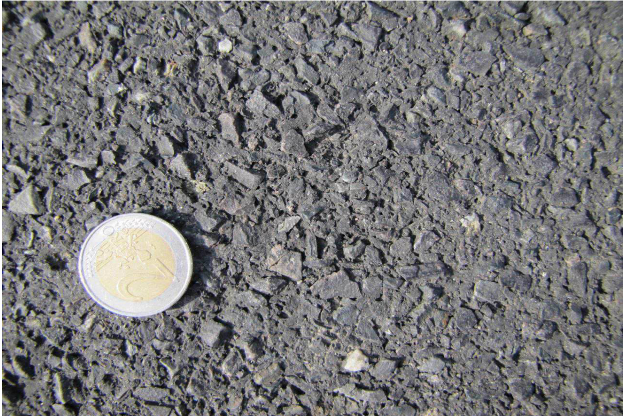
Detailaufnahme der Deckschicht:
