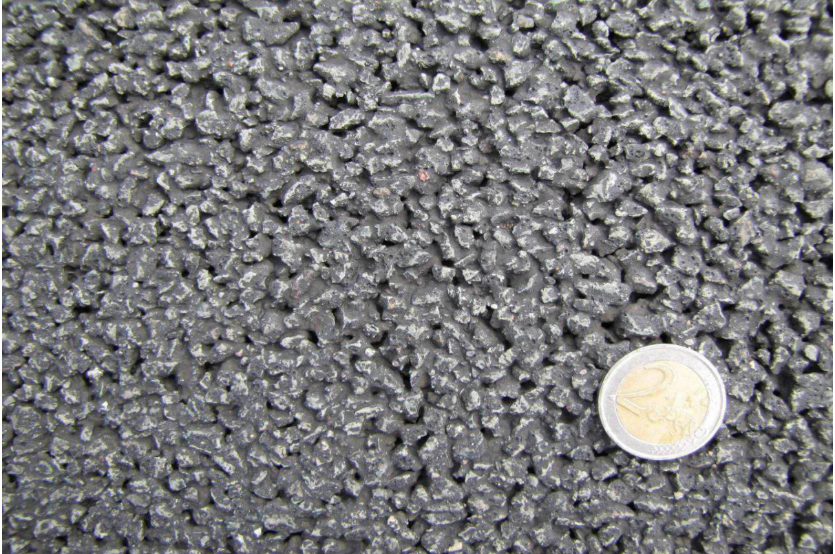
Detailaufnahme der Deckschicht:
