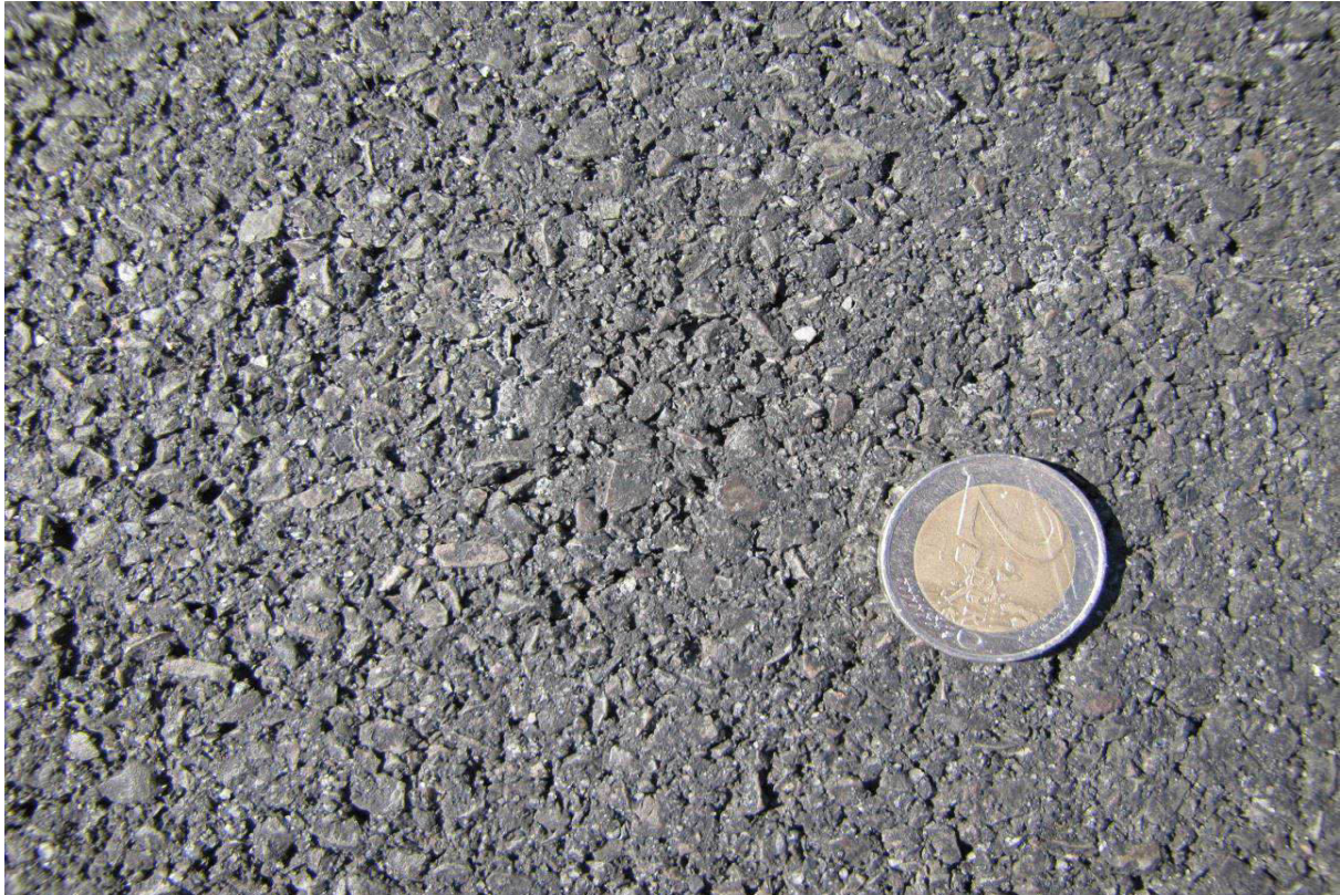
Detailaufnahme der Deckschicht:
