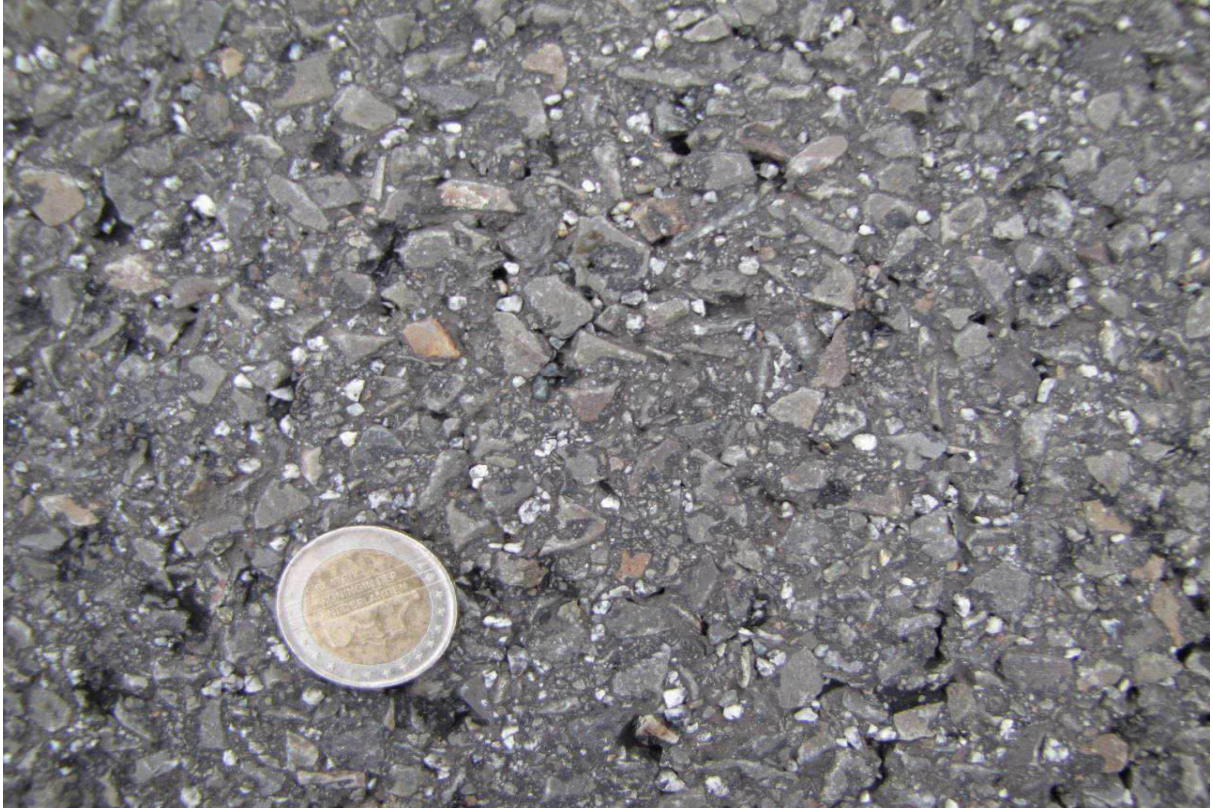
Detailaufnahme der Deckschicht:
