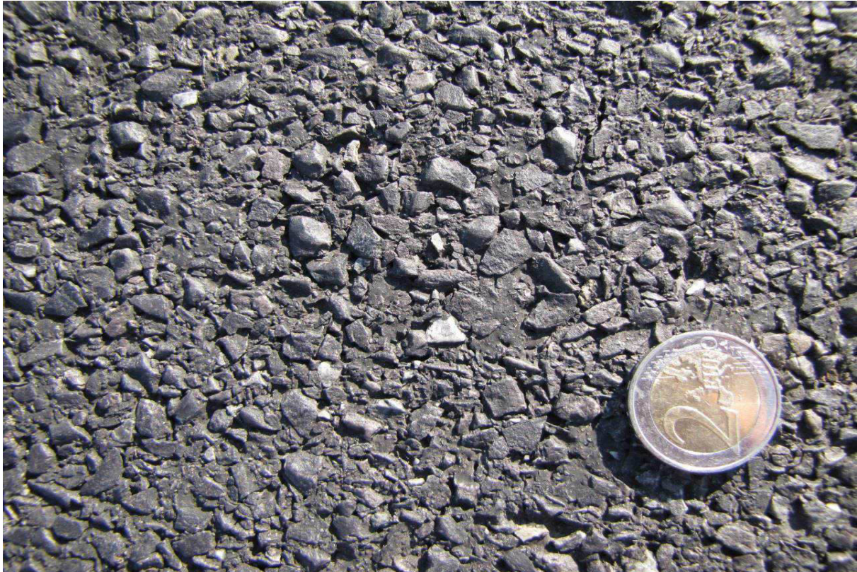
Detailaufnahme der Deckschicht:
