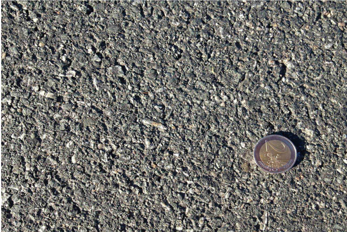
Detailaufnahme der Deckschicht:
