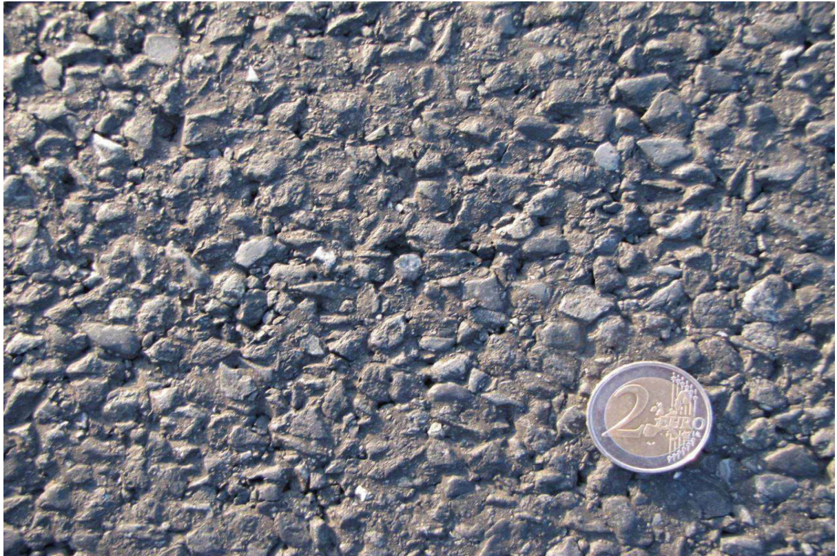
Detailaufnahme der Deckschicht:
