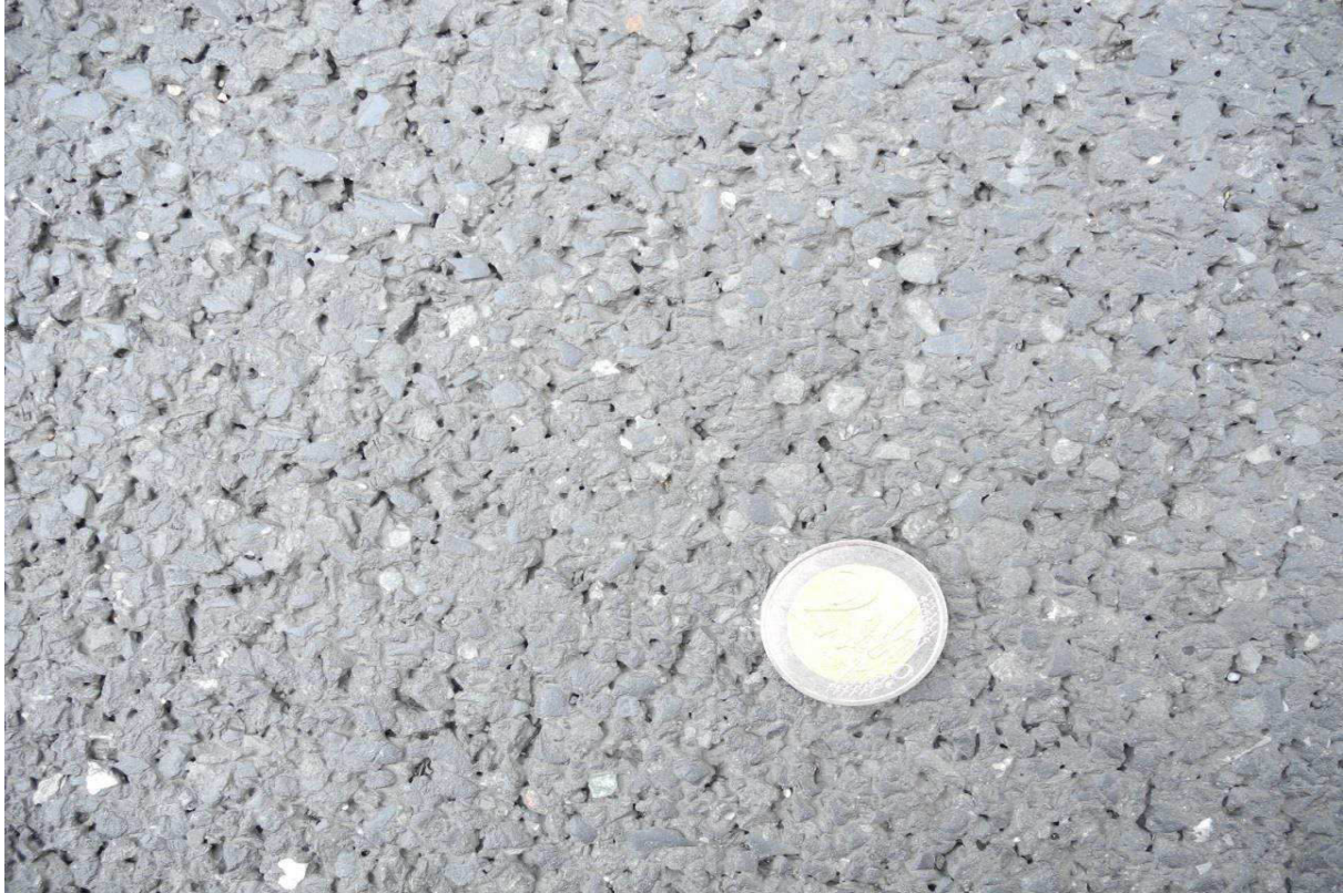
Detailaufnahme der Deckschicht:
