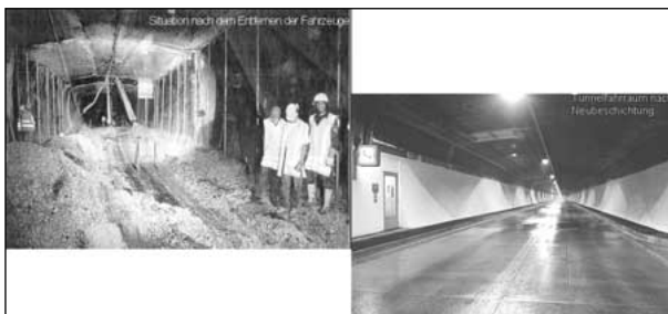
Modernisierung – Beispiel Tauern-Tunnel/Österreich
