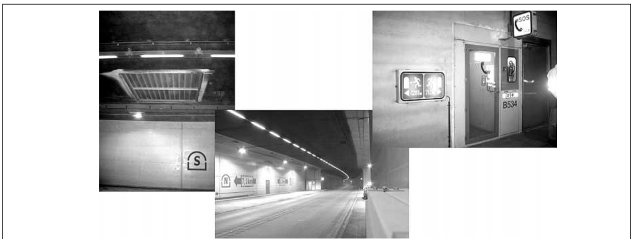
Modernisierung – Beispiel Gleinalm-Tunnel/Österreich
