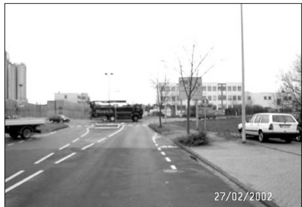
Bild 8: Der Vorwegweiser ist im Sommer hinter dem Baum nicht sichtbar
