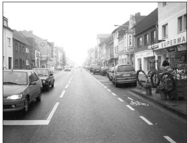
Bild 7: Typische Fehler – Radfahrstreifen nicht nutzbar
