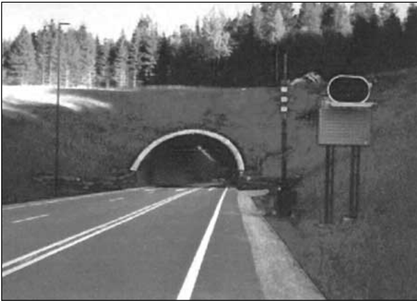
Bild 4: Automatische mechanische Tunnelsperrung bei Störfällen
