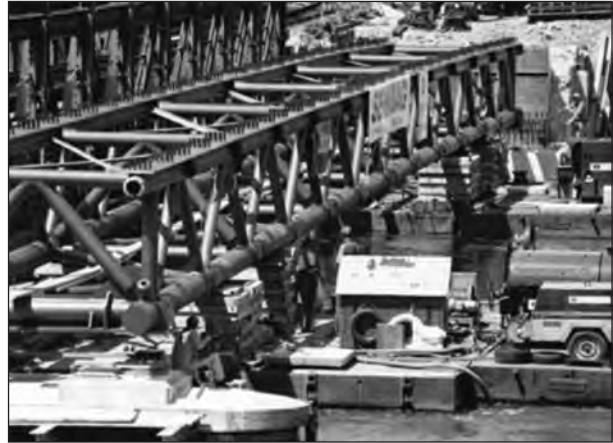
Bild 2.19: Aarebrücke in Aarwangen (Bauzustand)
