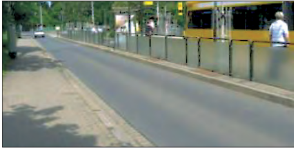
Bild 55: Sonderfall Querschnitt A5-3 (3,25-m-Fahrbahn neben Haltestelle)
