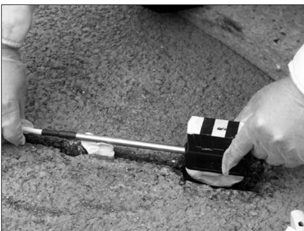
Bild 24: Sensor Fa. Vaisala – Einbauvorgang
