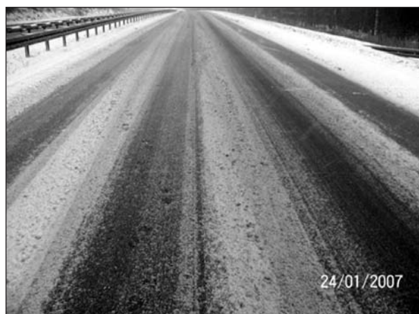
Bild 44: Fahrstreifen mit verstärkter Spurbildung am 24.01.2007; 9:40 Uhr
