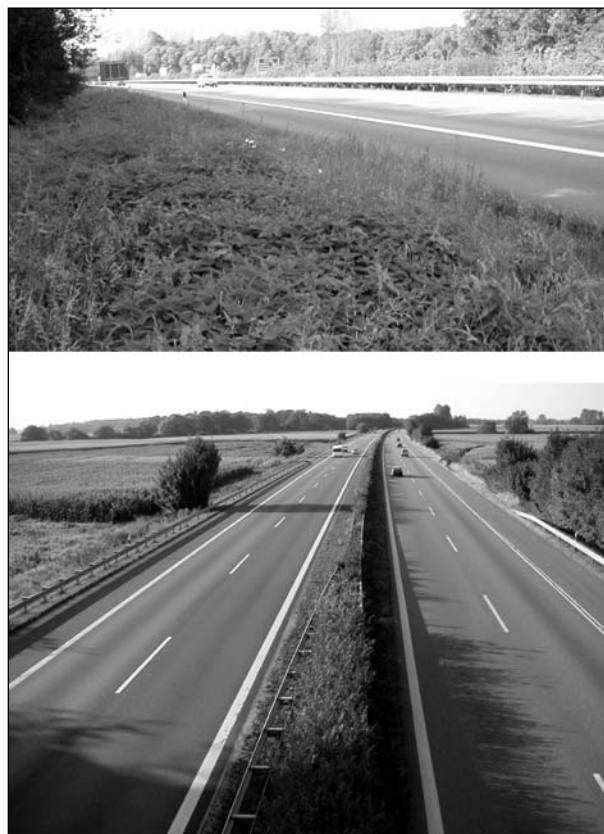
Bild 5.4: Ansicht der Messstellenbereiche an der BAB A 5 bei Holzhausen (oben) und Kenzingen (unten)
