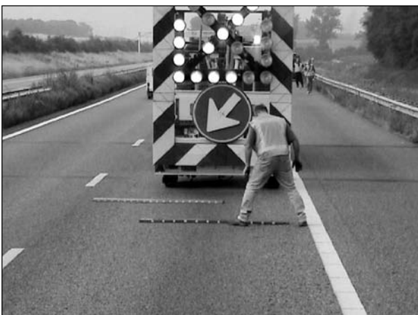
Bild 17: Verlegen der Andreasstreifen im Schutz eines Sicherungsfahrzeugs
