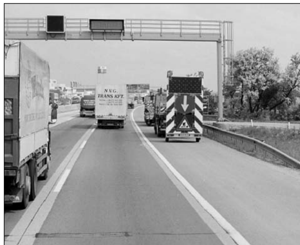
Bild 5: Fahrbare Absperrtafel in fluoreszierender Ausführung (Beispiel aus Österreich)
