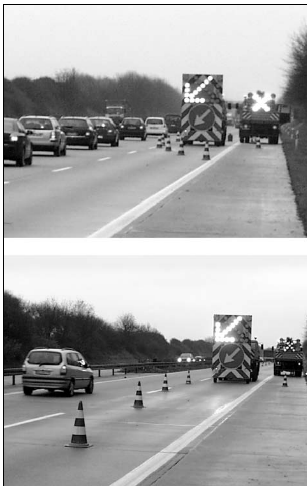
Bild 3: Anordnung von Leitkegeln vor der fahrbaren Absperrtafel
