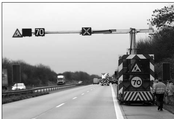
Bild 8: Einsatz einer mobilen Fahrstreifensignalisierung bei einem Pilotversuch auf der BAB A 61 bei Bedburg
