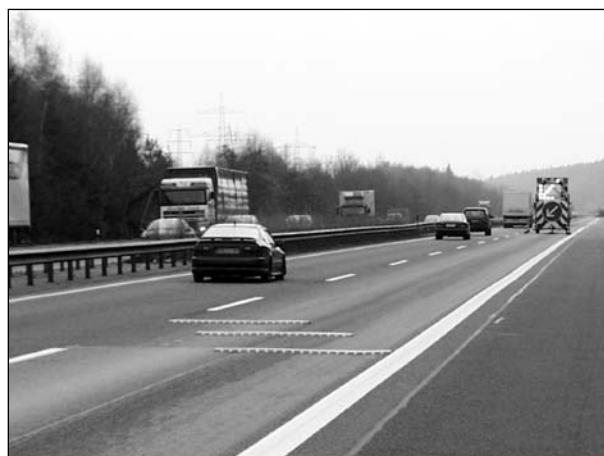
Bild 11: Einsatz von Andreasstreifen bei einer Arbeitsstelle kürzerer Dauer auf dem rechten Fahrstreifen
