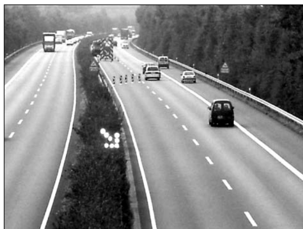
Bild 38: Arbeitsstelle kürzerer Dauer mit Sperrung des linken Fahrstreifens durch Querabsperrung mit Leitbaken auf der BAB A 43 bei Billerbeck (1.10.2003)
