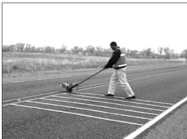
Bild 10: Aufbringen von Rumble Strips
