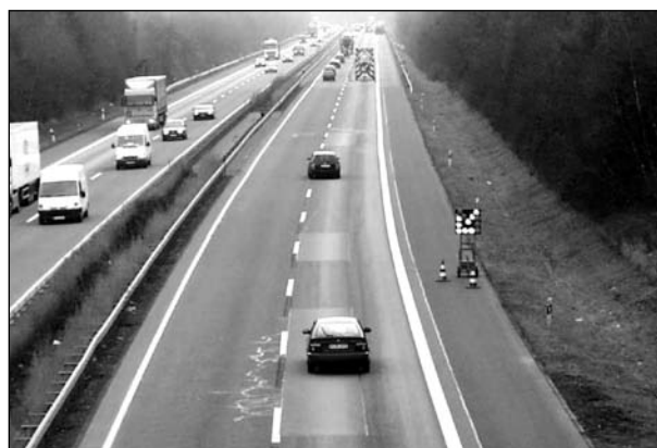
Bild 29: Vorgezogener kleiner Blinkpfeil bei Arbeitsstelle kürzerer Dauer mit Sperrung des rechten Fahrstreifens mit Andreasstreifen auf der BAB A 61 bei Laudert (3.12.2003)
