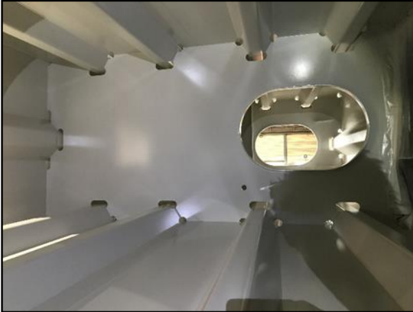
Bild 6: Hellweiße Beschichtung nach TL-Blatt 50 (Farbe: grauweiße, RAL 9002) [Foto: Fa. Donges SteelTec GmbH / Darmstadt]
