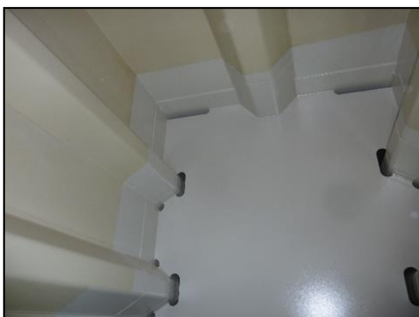
Bild 24: Fertiggestellte Innenbeschichtung [Foto: DEGEG GmbH]
