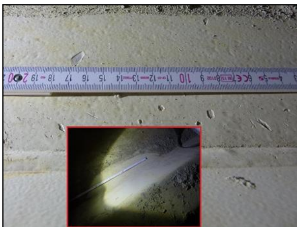
Bild 23: Mechanische Verletzungen [Foto: DEGEG GmbH]
