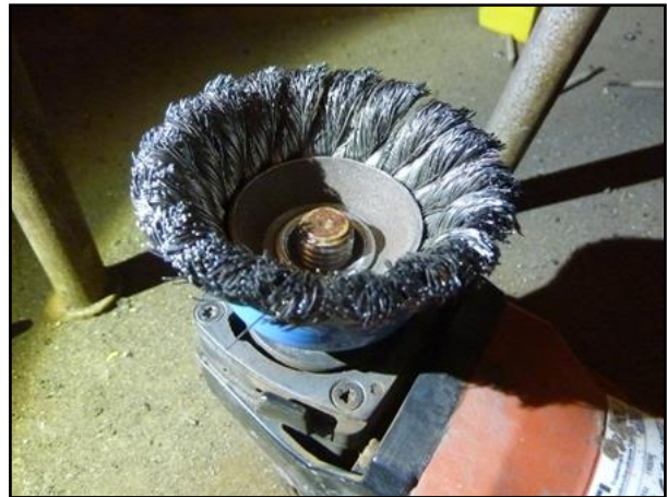
Bild 14: Oberflächenvorbereitung an den schwer zugänglichen Stellen mit rotierenden Bürsten [Foto: DEGES GmbH]
