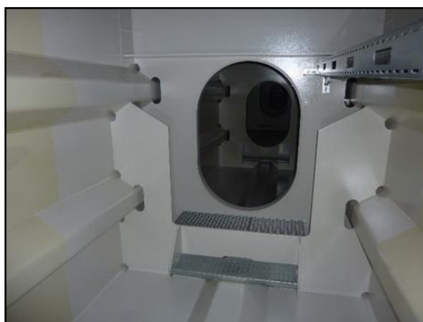
Bild 25: Fertiggestellte Innenbeschichtung [Foto: DEGEG GmbH]
