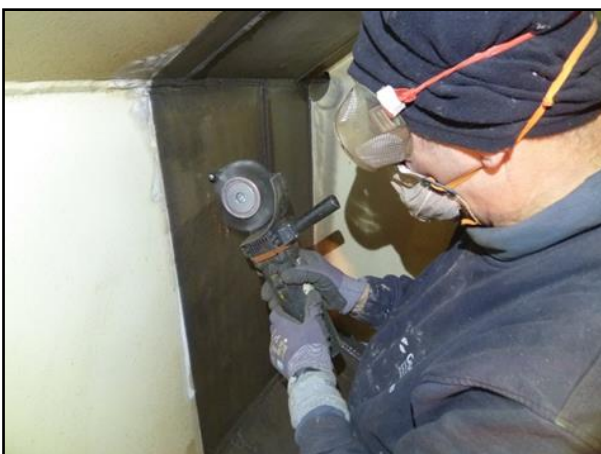
Bild 8: Oberflächenvorbereitung mit Bristle-Blaster der Fa. Monti [Foto: DEGES GmbH]
