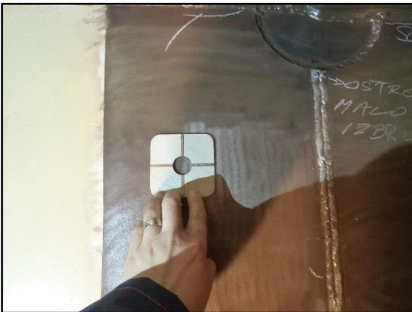
Bild 9: Oberflächenvorbereitung der Fläche [Foto: DEGES GmbH]
