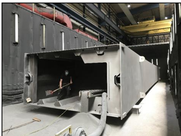
Bild 5: Transport des Mehrwegstrahlmittels aus den Hohlkästen im Werk von Hand und Mittels Förderband während einer Strahlpause [Foto: Fa. Donges SteelTec GmbH / Darmstadt]
