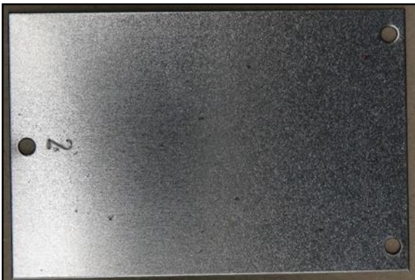
Bild 34: Stahlblech Vorderseite Bewitterung im Hohlkasten Achse C, im Bereich Einstiegs Luke zw. Achse 10/20
