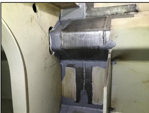
Bild 15: Vorgestrichene Flächen mit Sika Poxicolor Primer HE NEU [Foto: DEGES GmbH]
