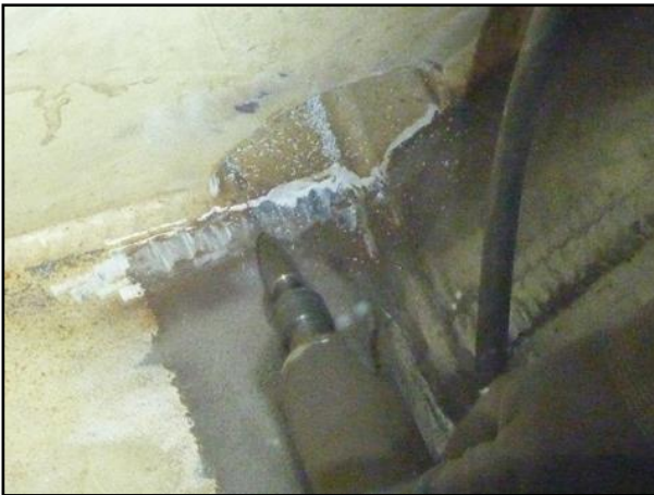
Bild 13: Oberflächenvorbereitung an den schwer zugänglichen Stellen mit dem Fräser [Foto: DEGES GmbH]
