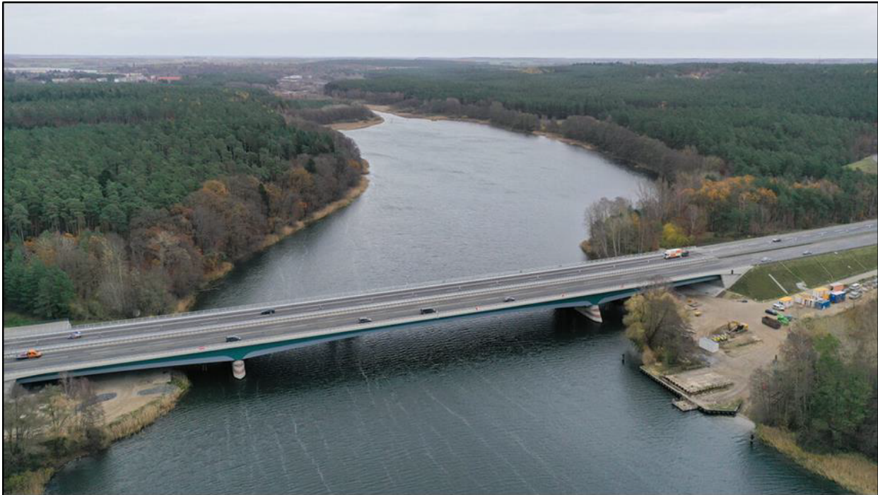
Bild 4: Vogelperspektive von Westen auf den Ersatzneubau der Brücke über den Petersdorfer See vom 20.11.2020 [Foto: Energieministerium Mecklenburg-Vorpommern]
