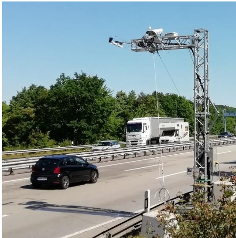
Bild 12: EDAR-System nach dem Aufbau im Messbetrieb
