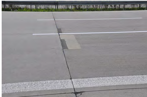
Abbildung 53: Tagesansatz mit Kantenschäden und Eckabbruch
