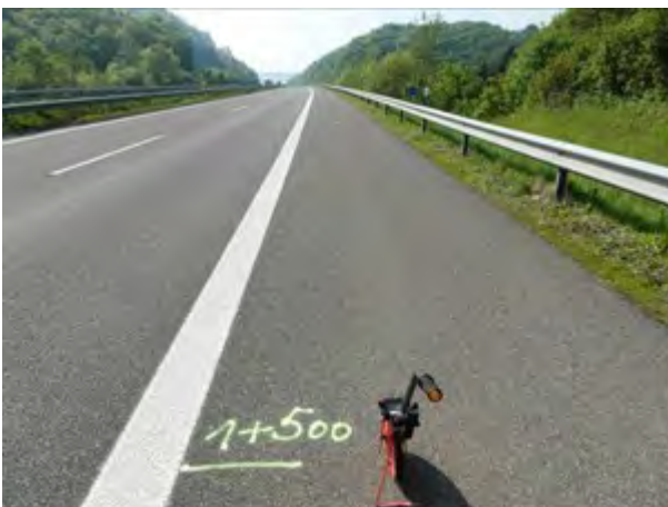
Abbildung 26: Anbringen von Stationierungsmarkierungen aller 500m
