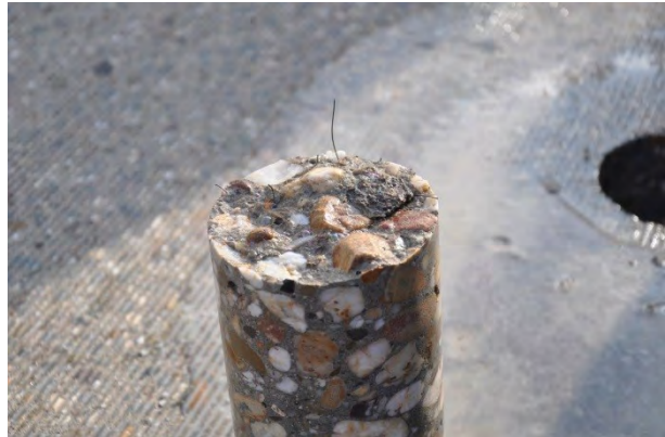
Abbildung 67: Bohrkern aus Stahlfaserbeton
