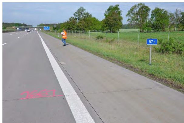
Abbildung 22: Plattengenaue Markierung auf der Fahrbahn an der Stationierungstafel
