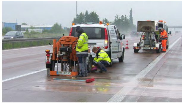
Abbildung 62: Bohrkernentnahme im ersten Fahrstreifen, hinten im Bild FWD-Messung
