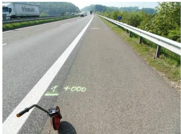
Abbildung 58: Erneuerung der Asphaltdeckschicht im Hauptfahrstreifen
