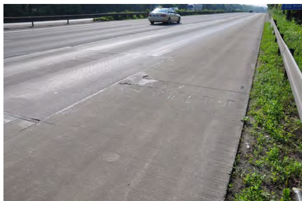
Abbildung 69: Plattenersatz im ersten Fahrstreifen
