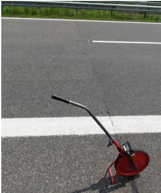
Abbildung 60: Erfassung von Abschnittsgrenzen (Tagesansatz in der Asphaltdeckschicht)
