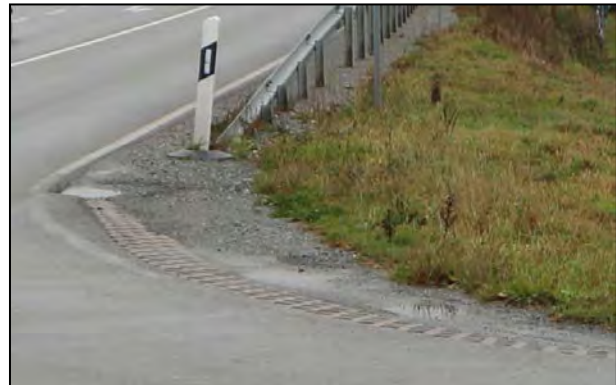
Bild 22 Beschädigung Eckausrundung an Knotenpunkten
