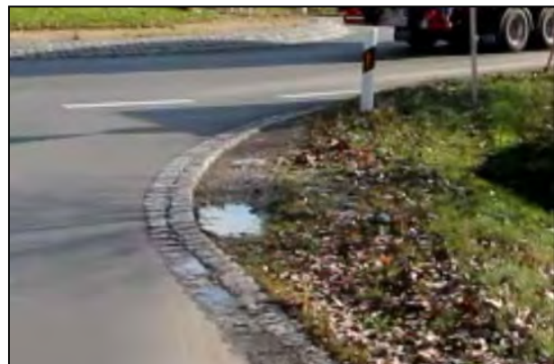
Bild 22 Beschädigung Eckausrundung an Knotenpunkten
