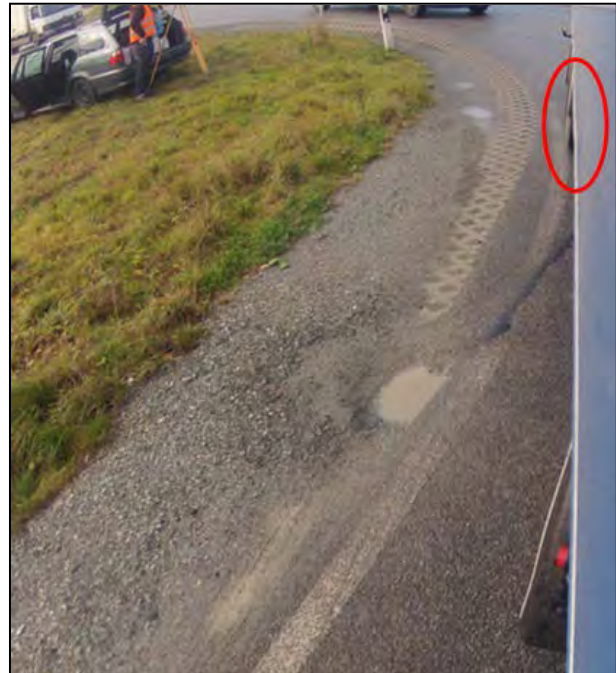
Bild 54 Abgenutzte Markierung im ausleitenden Radius der Eckausrundung
