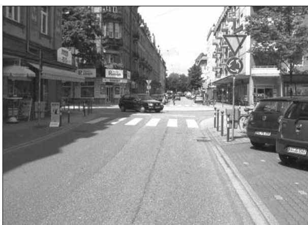
Bild 28: Minikreisverkehrszufahrt mit Fußgängerüberweg
