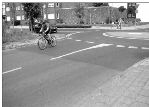
Bild 30: Minikreisverkehrszufahrt ohne Bordabsenkung
