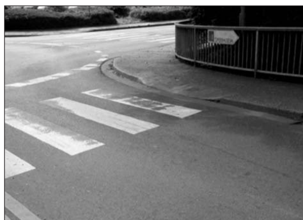
Bild 31: Minikreisverkehrszufahrt mit Bordabsenkung
