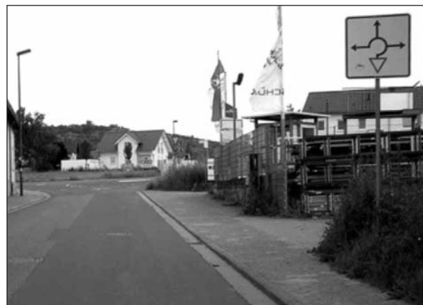
Bild 27: Minikreisverkehrszufahrt mit Hinweisschild
