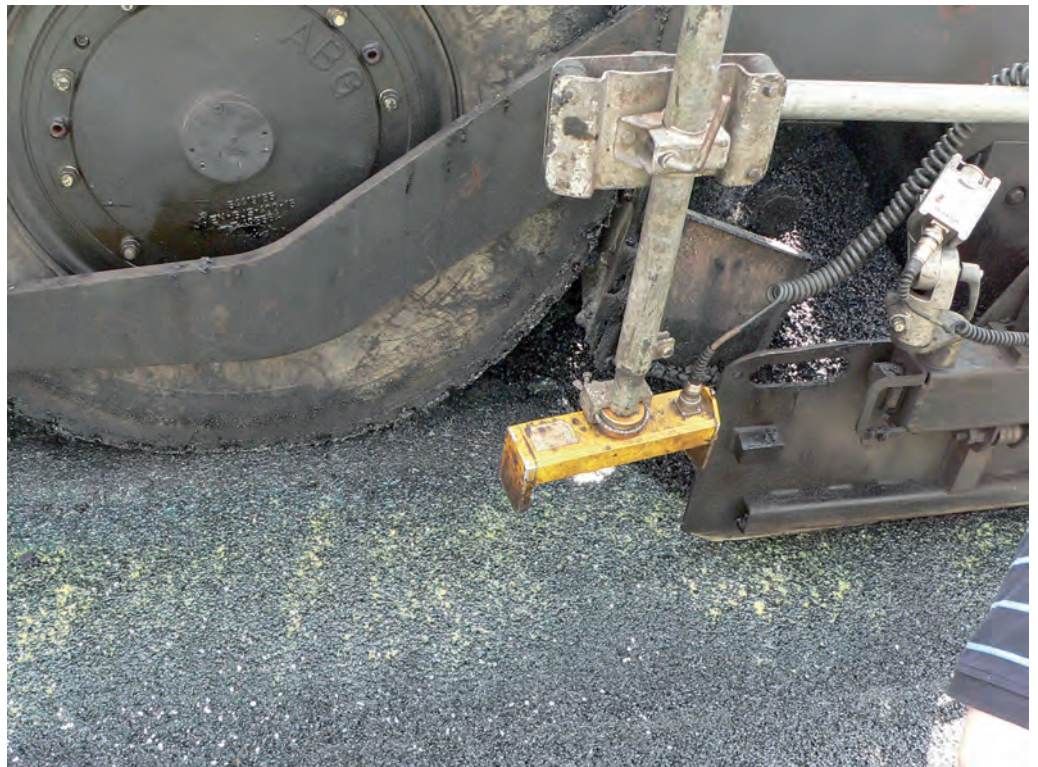
Einbau der Walzasphaltdeckschicht auf nicht ausgehärtete Abdichtung
