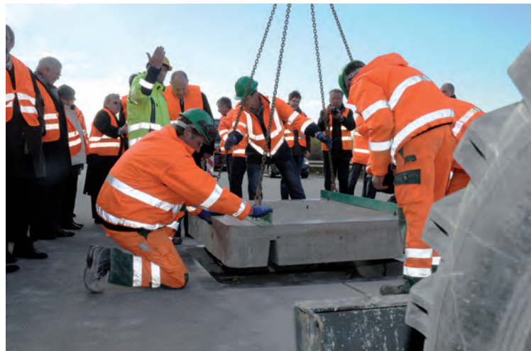
Einbau des Betonfertigteils auf der A9
