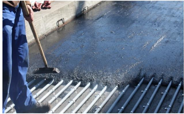
**Bilder 12 + 13:** Einbau der MA-Zwischenschicht
