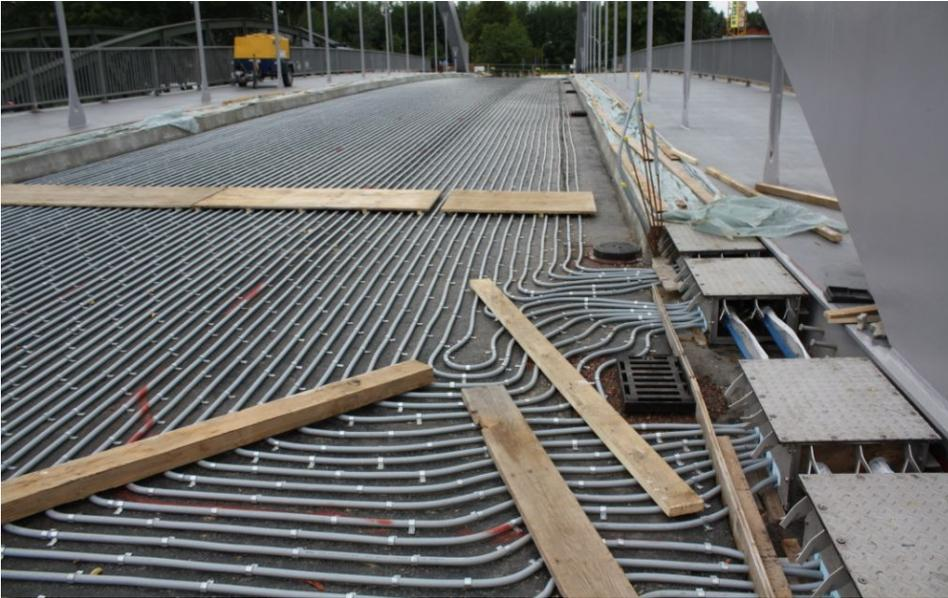
**Bild 11:** Fertig verlegtes FTR auf dem Überbau mit Anbindung der Einzelkreise an die Verteiler im Vor- und Rücklauf (August 2010), unmittelbar vor dem Einbau der MA-Zwischenschicht
