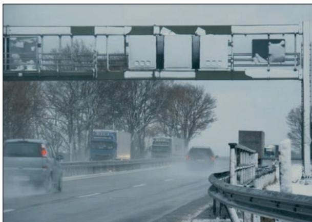
**Bild 48:** Zugeschneite Anzeige der VBA, BAB A 8 Ost, Bereich Siegsdorf (GÖTZ, 2007)
