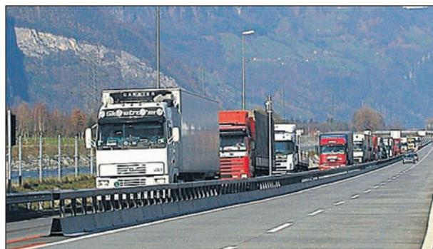
**Bild 28:** Baulich zur Fahrbahn abgetrennter Aufstaubereich in der Schweiz (MEIER, 2007)
