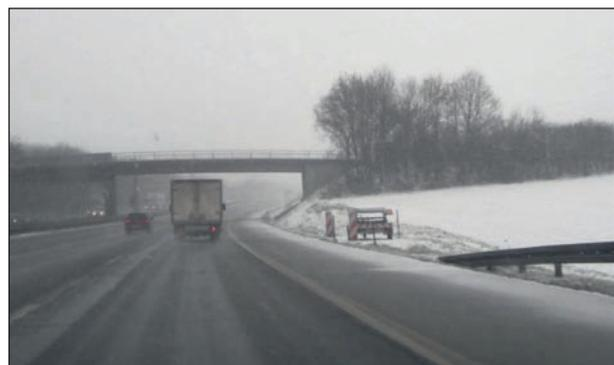
**Bild 46:** Platziertes LED-Vorwarner mit Leitbaken neben dem Seitenstreifen
