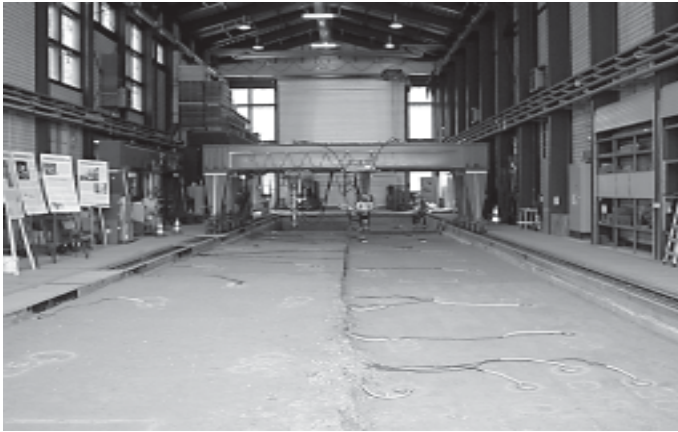
Einbau der Straßenkonstruktion in der Modellstraße der BASt
