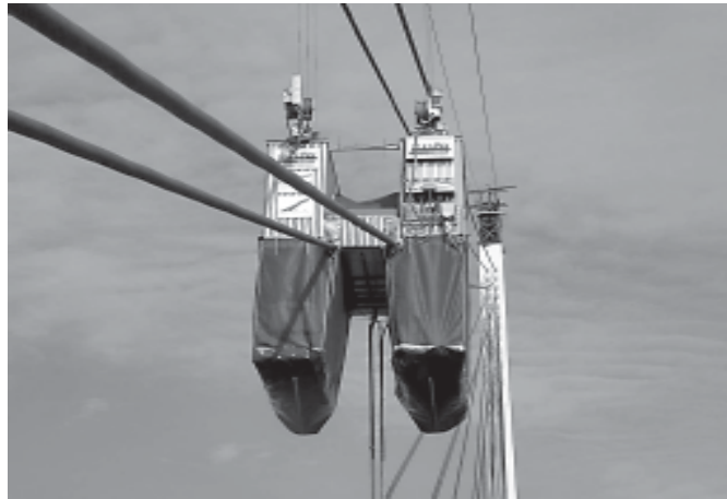
Moderne Trockeneisstrahlkabine mit Laufwagen
