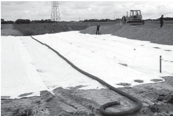
Geokunststoffgewebe und Horizontaldränage in der Dammaufstandsfläche
