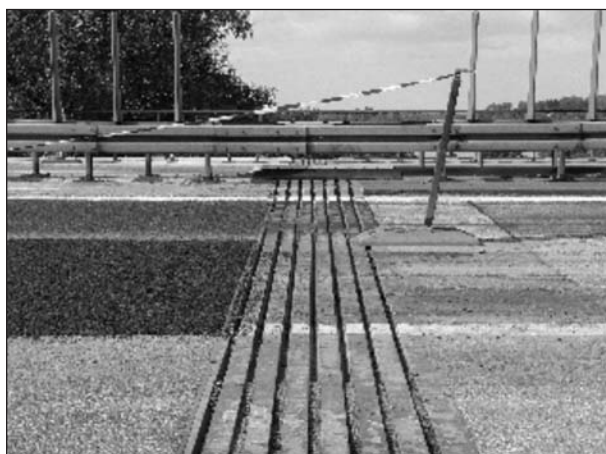
Bild 5-21: Fahrbahnübergang in Lamellenbauweise ohne Lärminderung
