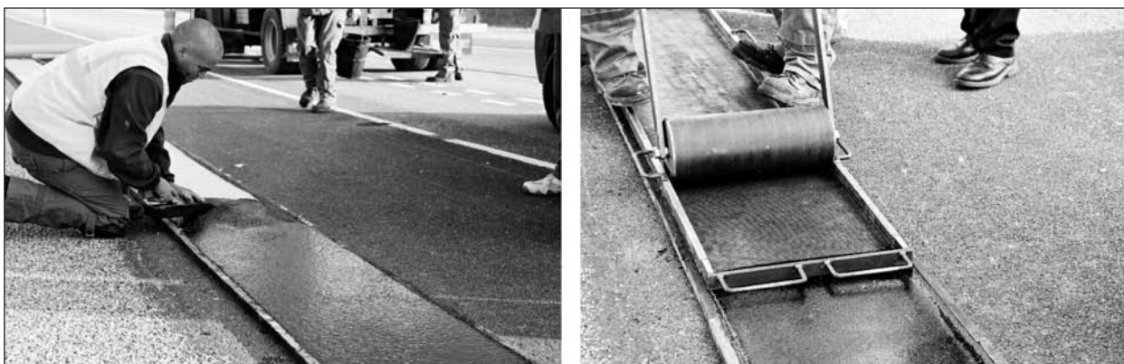
Bild 1-9: Einbau des „ITARI-Belags“ in Asphaltdeckschicht in Lyon [1]
