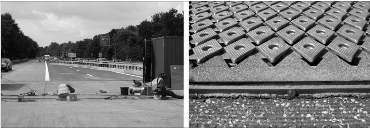
Bild 5-22: Einbau des neuen Fahrbahnüberganges mit lärmoptimierten Oberflächen
