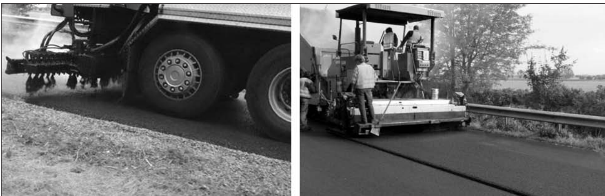
Bild 5-14: Herstellung der Abdichtung (links) und Einbau des Asphaltmischgutes (rechts)
