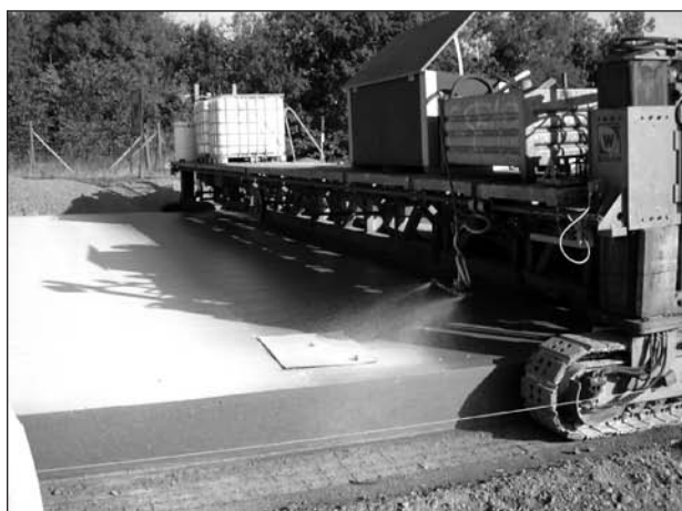
Bild 5-5: Aufbringen des Entaktivierers und Ausbürsten der Mörtelschicht zur Herstellung von Waschbeton
