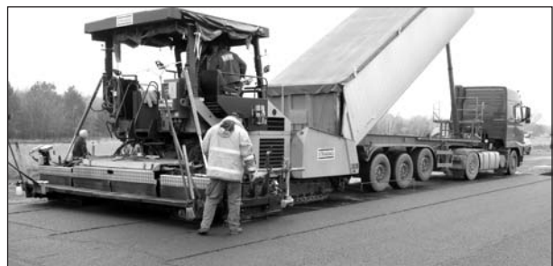
Bild 4.5-36: Beschickung des Straßenfertigers mit Mischgut
