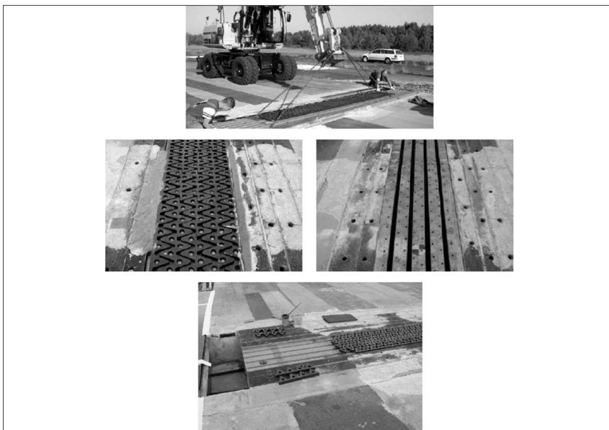
Bild 4.6.1-16: Beispiel für den Einbau der Dämpfungsabdeckung in Sperenberg
