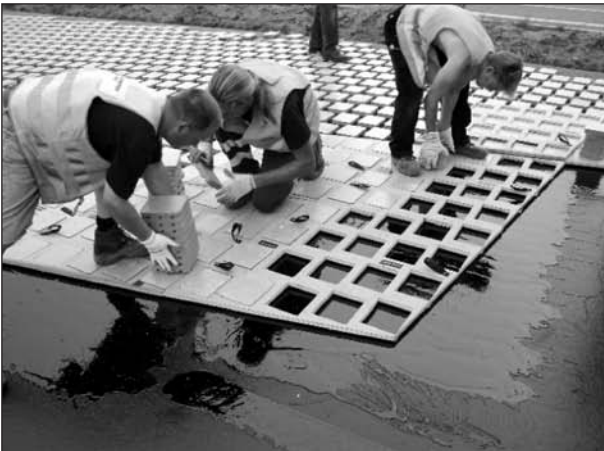
Bild 5-18: Einbau der Resonatoren im Abschnitt 5 der BAB 24 am 30.06.2009
