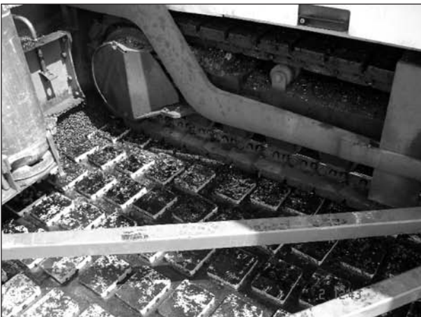
Bild 5-19: Einbau A 24 – Überdeckung der Resonatorelemente mit PA 11
