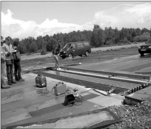
Bild 4.6.1-35: Vorbereitung des Fahrbahnübergangs im Messfeld B17
