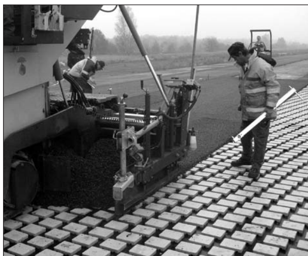
Bild 4.5-37: Einbau der unteren Lage auf dem OPAR-Testfeld
