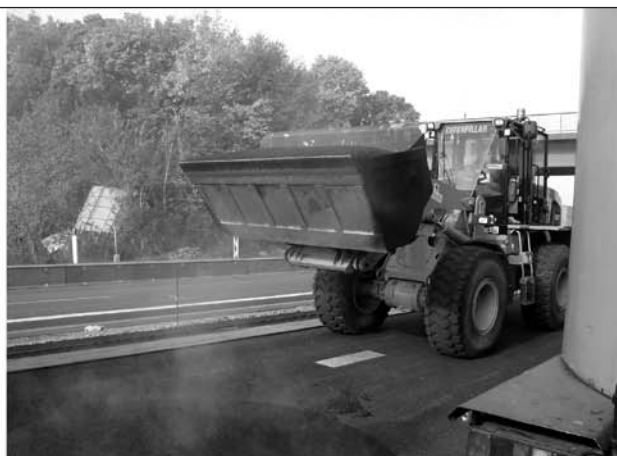
Bild 5-12: Einbau der Gussasphaltschicht und Abstreuung der Oberfläche (links) und Radlader zur Beschickung des Splittkastens (rechts)
