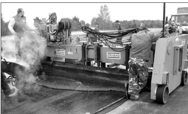
Bild 4.5-30: Herstellung der Gussasphaltschicht mit einer Einbaubohle
