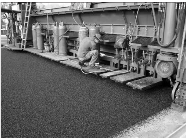
Bild 5-12: Einbau der Gussasphaltschicht und Abstreuung der Oberfläche (links) und Radlader zur Beschickung des Splittkastens (rechts)
