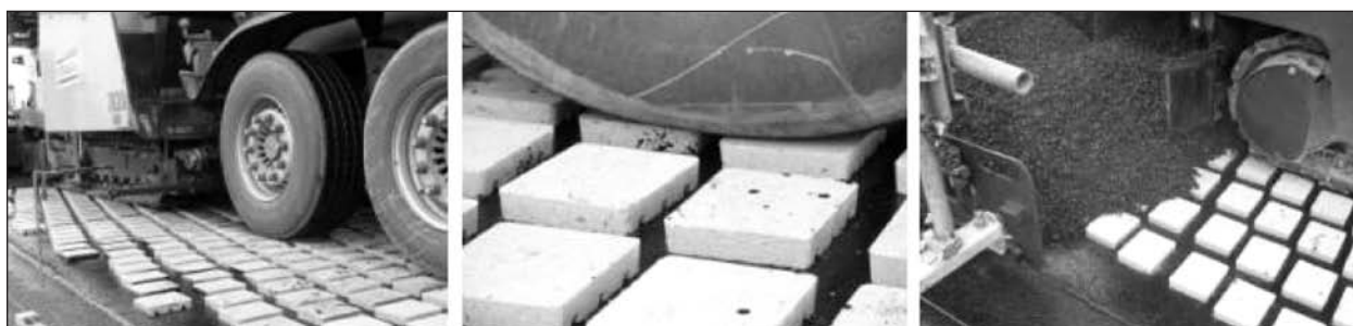
Bild 4.5-38: Lkw-Reifen bei der Überfahrt über die Resonatorelemente und Verteilung des Mischguts in den Zwischenräumen
