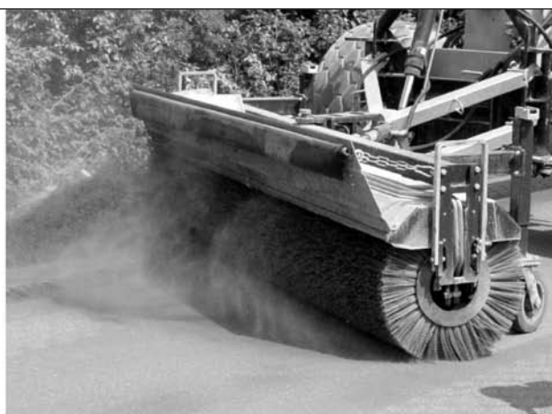
Bild 5-5: Aufbringen des Entaktivierers und Ausbürsten der Mörtelschicht zur Herstellung von Waschbeton
