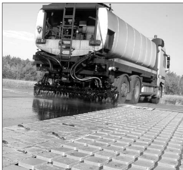
Bild 4.5-32: Spritzrampe zum Aufbringen der Bitumenemulsion
