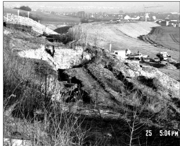
Bild 13: Rund 100.000 Kubikmeter Fels sind aufgrund nicht eingebauter Felsnägel ins Rutschen gekommen
