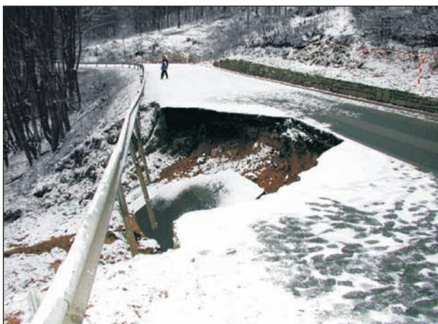
**Bild 5:** Plötzlicher Böschungsbruch durch Aufweichen von feinkörnigem Dammschüttmaterial
