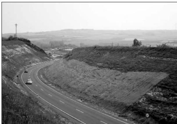
**Bild 4:** Erosionsschutzmatte als Sicherung
