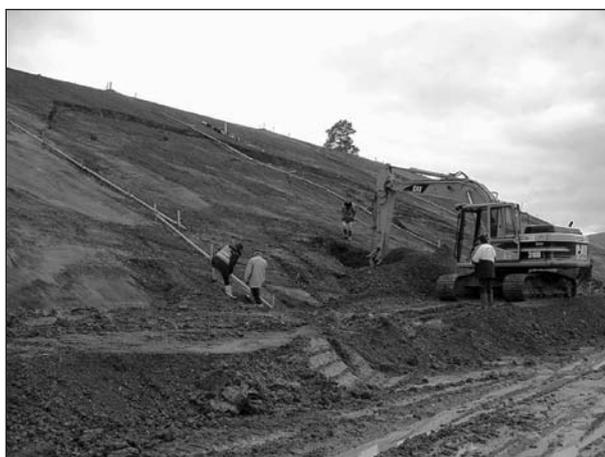
**Bild 5:** Flache Rutschung in der Einschnittböschung
