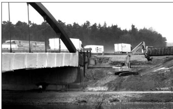
**Bild 4:** Erdbaumaßnahmen für die nördliche Fahrbahn- und Brückenhälfte
