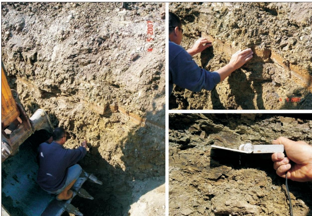
**Bild 1:** Beurteilung des Schichteneinfallens baubegleitend im Schurf
