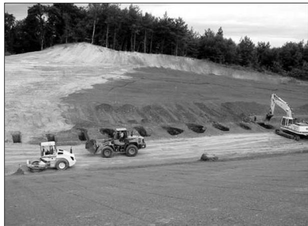
Bild 3: Aktivierter Rutschung (südwestliche Böschung)
