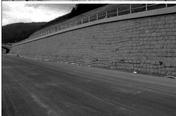
**Bild 3:** Vernagelte Spritzbetonschale mit Verblendungsmauerwerk
