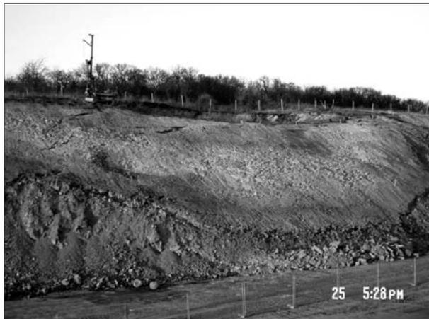
Bild 12: Gebrochene Böschung mit Bohrggerät zum verspäteten Inklinometerbau. Aufgrund des unkoordinierten, mangelhaften Zusammenwirkens von Bauüberwachung und Bauleitung des ausführenden Baubetriebes hat die an anderer Stelle bewährte Herangehensweise hier nicht funktioniert
