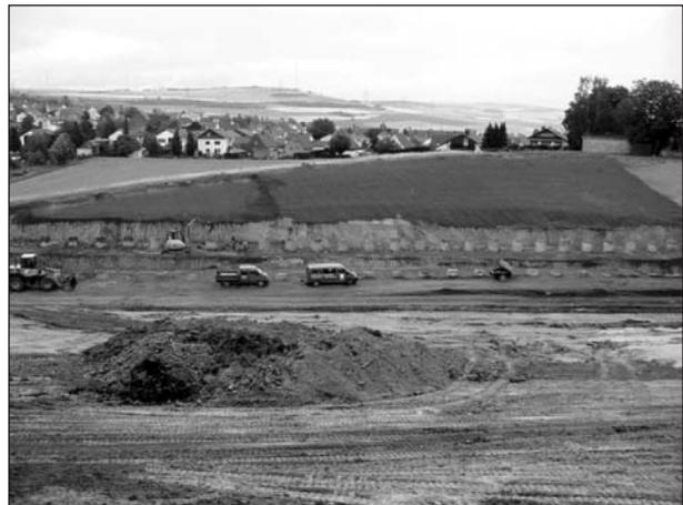
Bild 2: Sanierung der nordöstlichen Böschung
