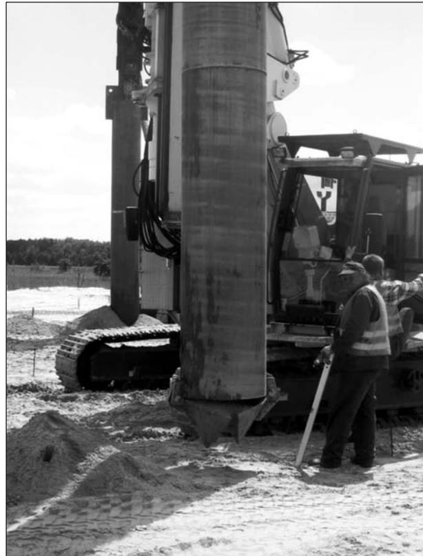
Bild 4: Herstellung der Sandsäulen im Rüttelverdrängungsverfahren
