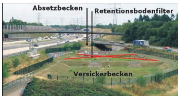
Bild 3: Optimierung von Entwässerungsanlagen
