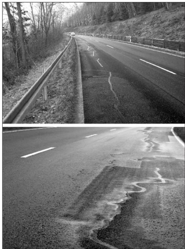
**Bild 3:** Risse im Straßenoberbau, verursacht durch eine instabile Böschung/Anschüttung
