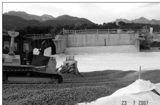
**Bild 2:** Einbau von Glasschaumgranulat
