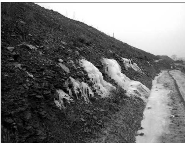
**Bild 1:** Beispielhaft ist auf dem Bild ein Einschnitt im Buntsandstein mit einer Wechsellagerung aus Sand- und Tonstein und Schichteinfallen in Richtung Straße zu sehen. Das Wasser tritt oberhalb der eingeschalteten Tonsteinschichten aus
