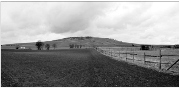
Bild 13: Das Rutschareal Wißberg mit Blick nach Norden, Aufnahme vom 28.03.2010
