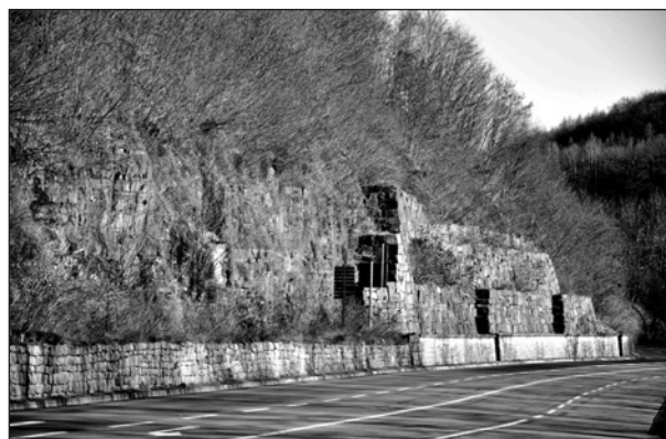
Bild 4: Schutz- und Stabilisierungsmaßnahmen an der Altmündener Wand, Aufnahme vom 02.04.2010
